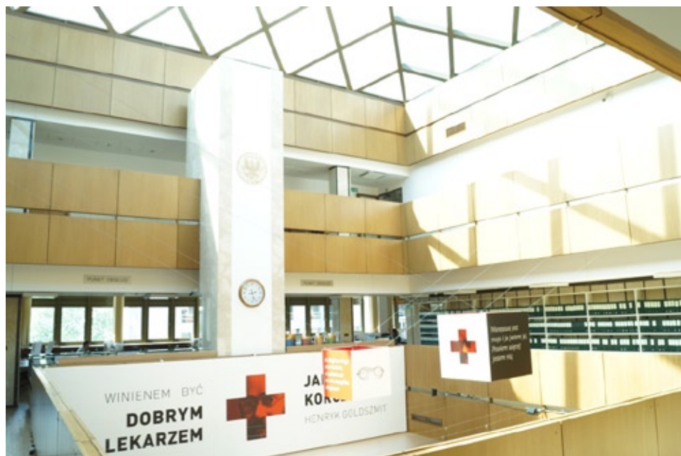
Oszklony dach w kształcie świetlika
