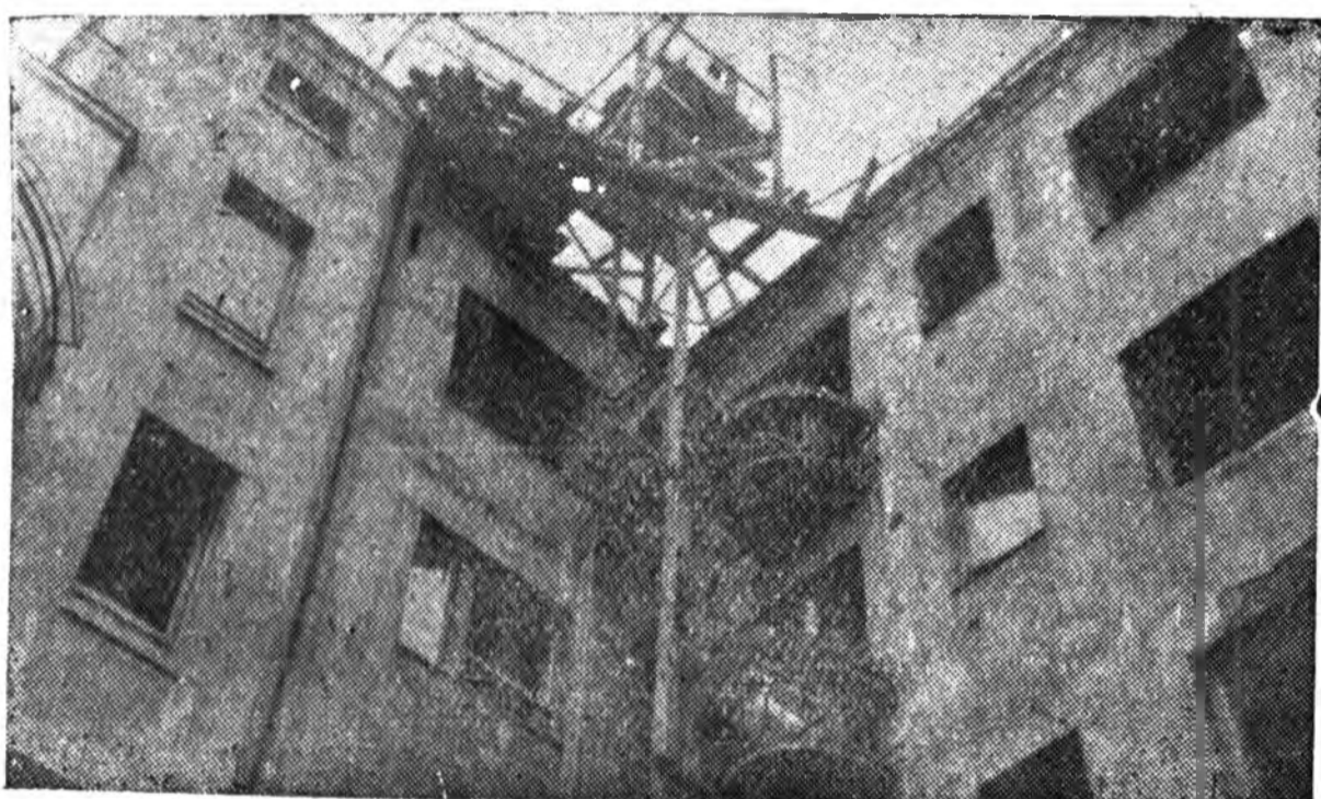
Fig. 2. Widok na konstrukcję pomostu wyciągowego windy drewnianej.
