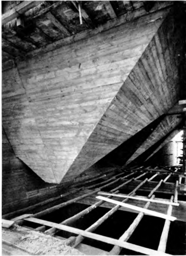
Abb. 42. Bunkertaschen der Bekohlungsanlage
