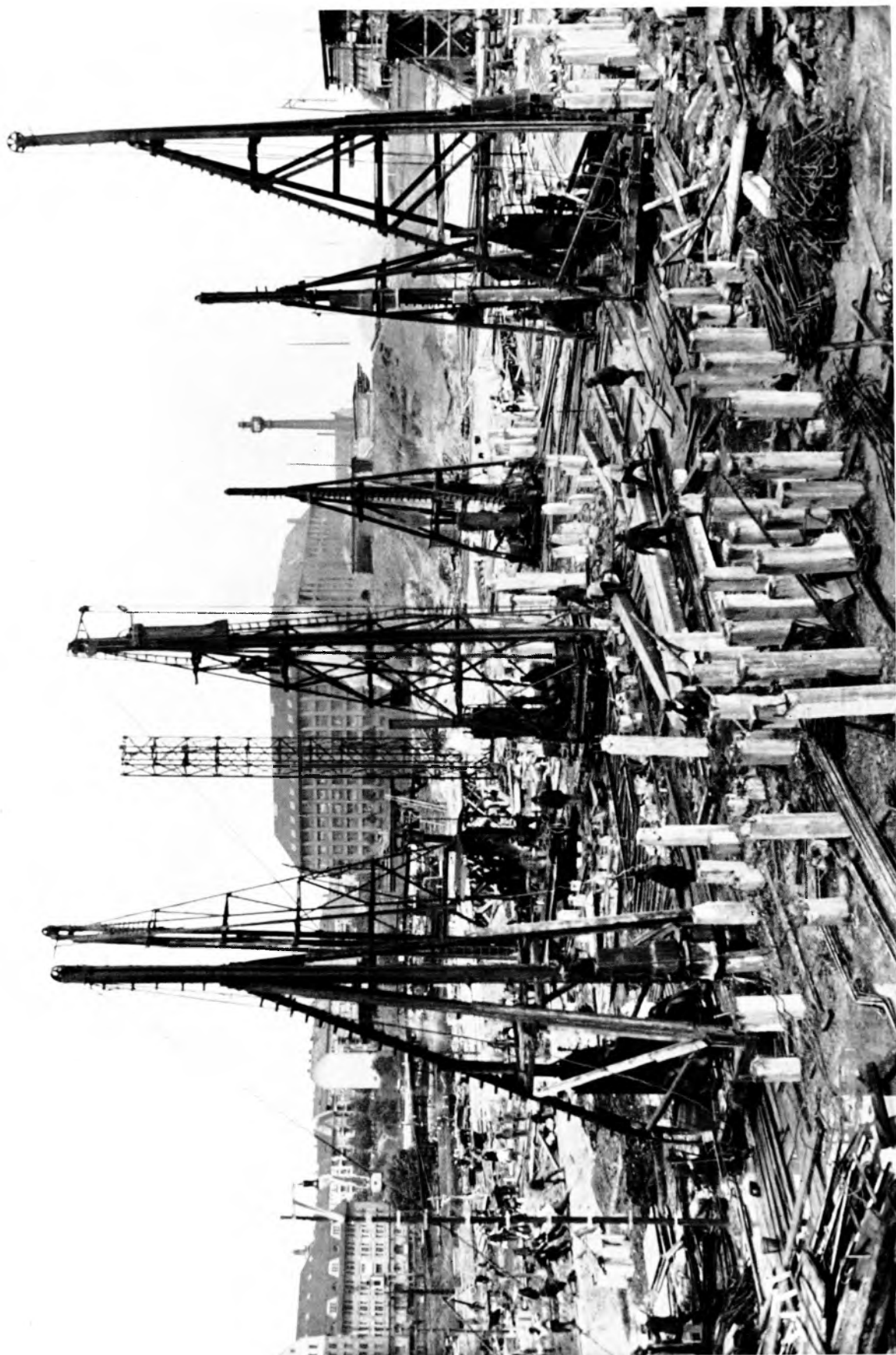
Abb. 11. Rammarbeiten im vorgezogenen Flügel (Bauteil Ia). Die Rammpfähle sind zum Teil noch nicht auf das erforderliche Maß gekappt. Man sieht einzelne, durch die Rammarbeit beschädigte Pfahlköpfe
