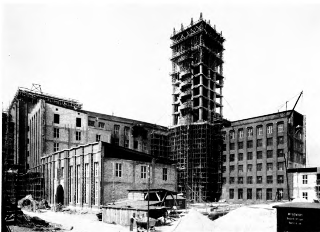
Abb. 80. Stand am 24. August 1926. Tordurchfahrt fertiggestellt; das VII. Obergeschoß des Bauteils Ia (links) wird aufgemauert. Für das Betontraggerüst des Turmes wird das XIII. Obergeschoß eingeschalt. Der Gießturm I reicht nur bis zum XII. Obergeschoß, von da Sonderaufzug; an der Hofseite des Turmes die auskragenden Podeste der Treppe
