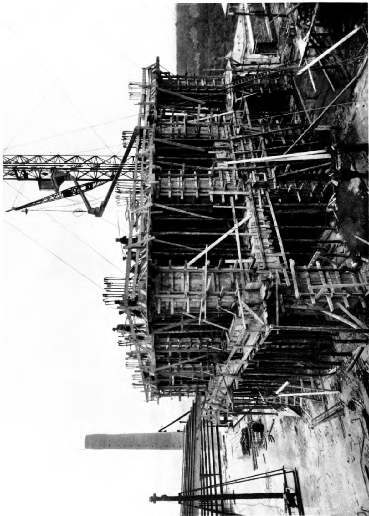
Abb. 34. Turm. Betonieren der Decke über dem VII. Obergeschoß
