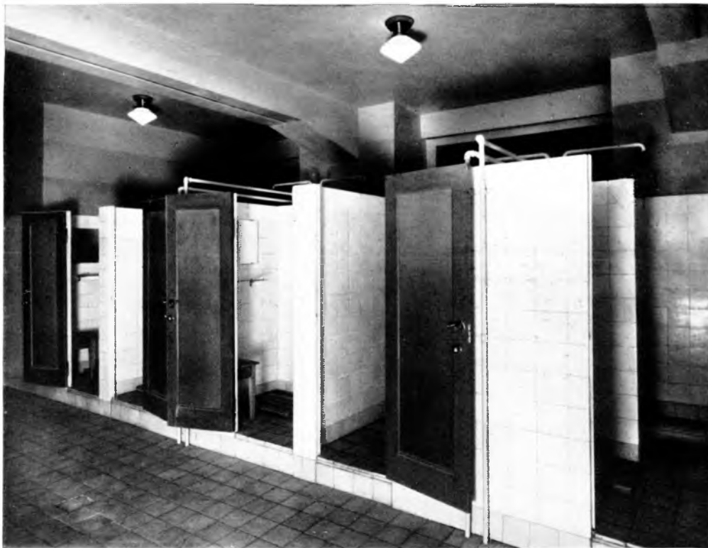
Abb. 107 Brausebäder der Männergarderobe. Unter der Brause ein vertieftes Becken. Wände weißer Plattenbelag, Fußboden gesinterte und geriffelte Platten auf Asphaltdichtung
