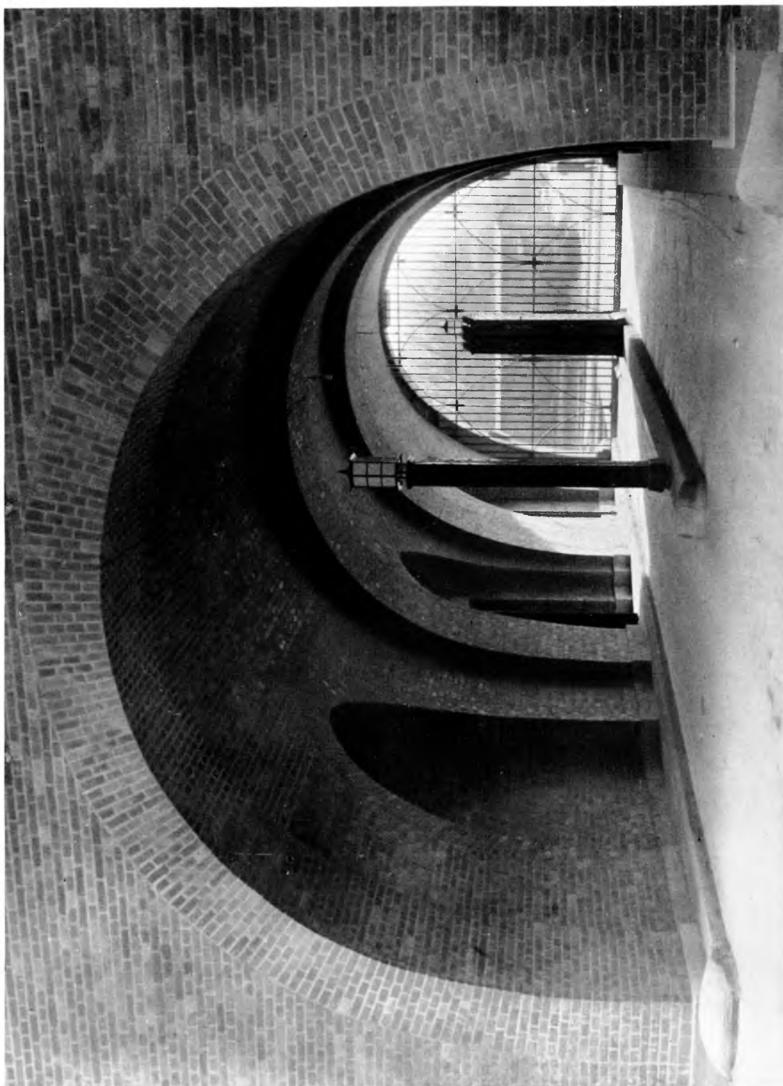
Abb. 125. Blick in die Durchfahrt vom Hof aus. Das versenkbare Gittertor ist hochgezogen, das weiter vorn stehende, eisenblechbeschlagene Tor ist zusammengeklappt. Die Ausführung des Mauerwerkes der Durchfahrt war durch die konische Form erschwert
