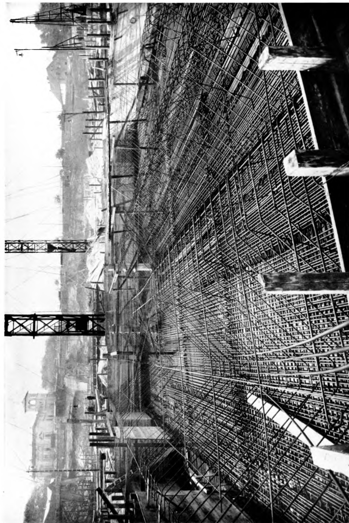
Abb. 14. Eisenbewehrung des Turmfundamentes während der Flechtarbeiten an den aufgezogenen Eisen. Die obere Bewehrung ist noch nicht eingebracht
