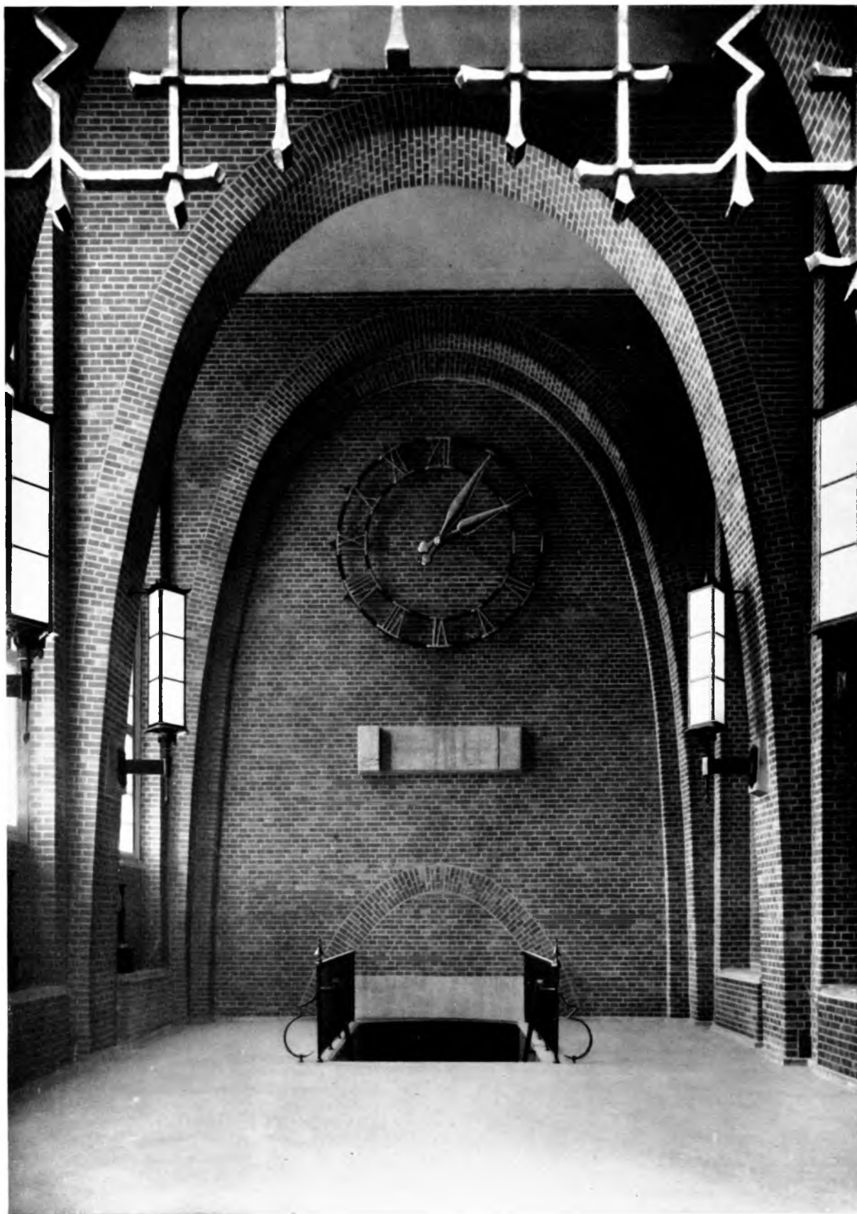
Abb. 122. Arbeitereingangshalle, 10 m hoch, mit Treppe zu den Garderoben. Links Fenster mit bunter Kunstverglasung. Fußboden in Travertin. Decke grüner Terranovaputz. Wände hellgefugte Klinkerverblendung, schmiedeeiserne Lampen
