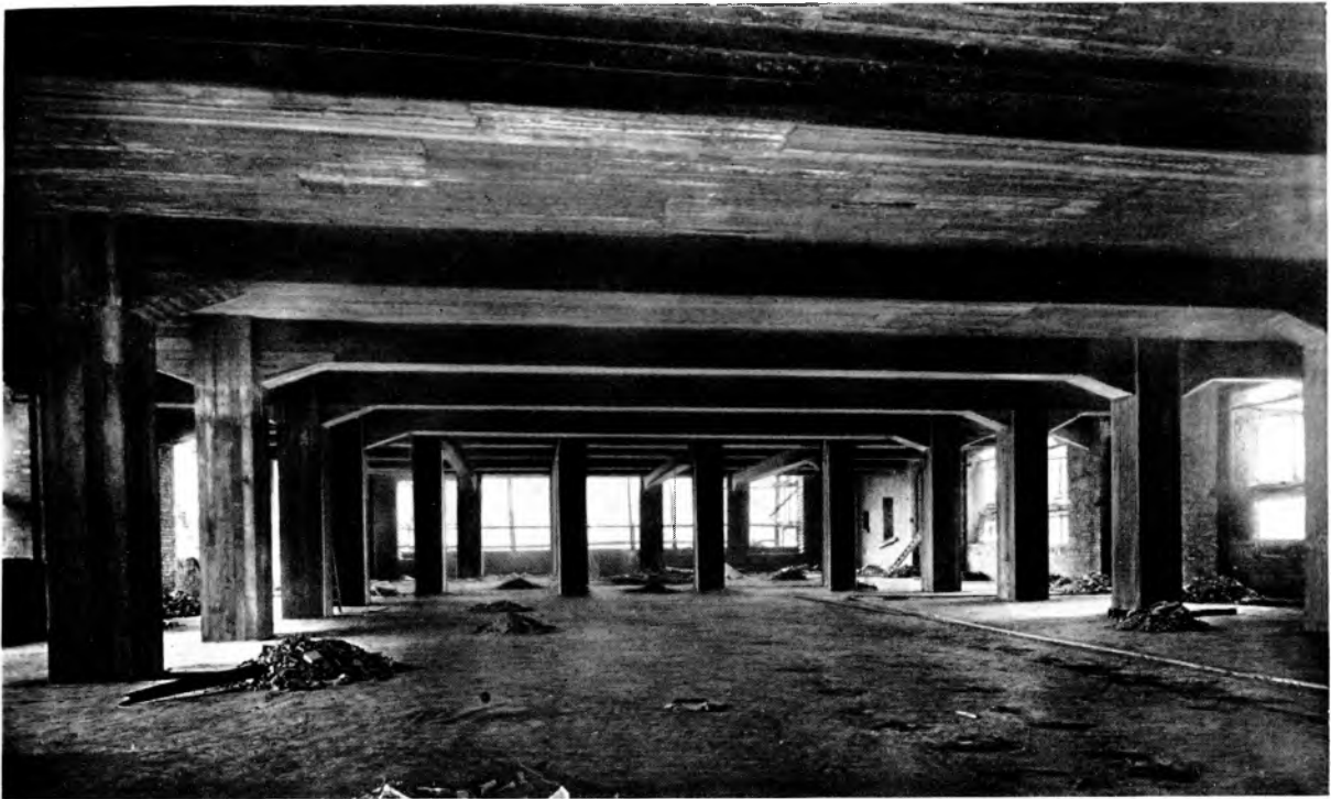
Abb. 37. Eisenbetontragwerk in Bauteil Ia, II. Obergeschoß. (Verwaltungsräume)
