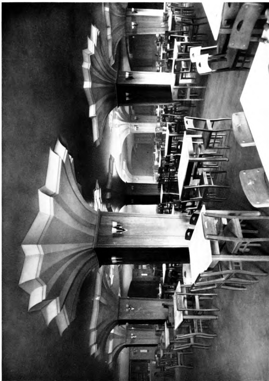
Abb. 100. Kantine. Wände und Pfeiler in Kiefernholz mit Sandstrahlgebläse behandelt und gewachst. Säulenköpfe der Pilzdecke in Stuck, Decke in rotbraun getönter Ölfarbe
