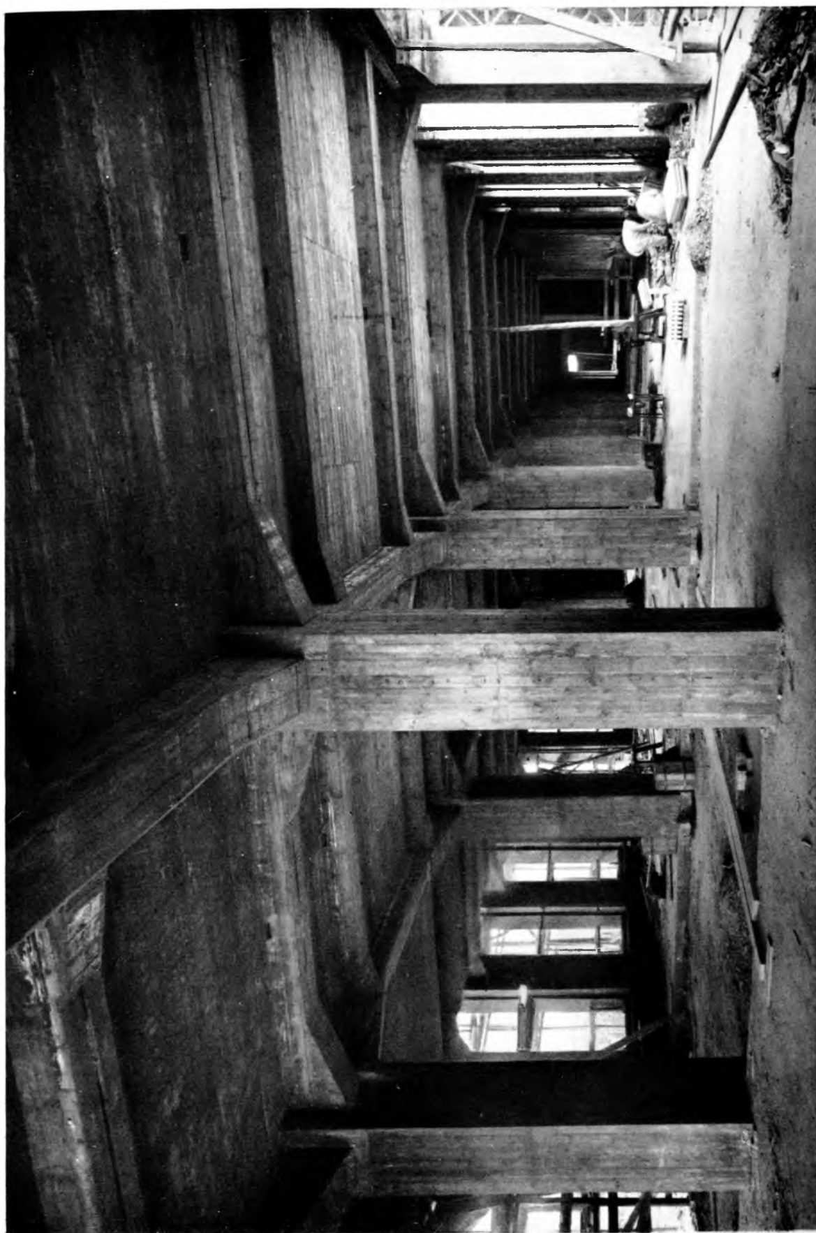
Abb. 23. Ausgeschaltete Eisenbetonkonstruktion, Bauteil III, Erdgeschloß
