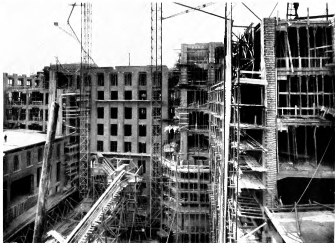
Abb. 76. Hof mit Förderband für die Mischmaschinen; links Durchfahrt ausgeschalt
