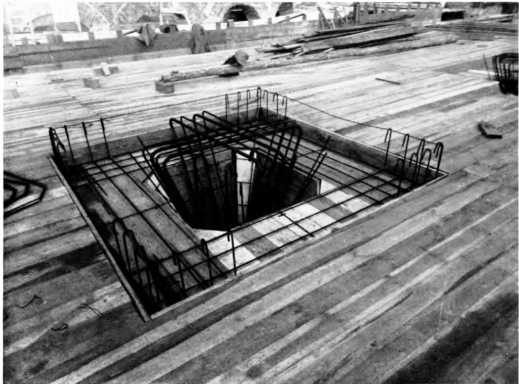
Abb. 44. Pilzdecke über der Kantine; Bewehrung des Pilzkopfes
