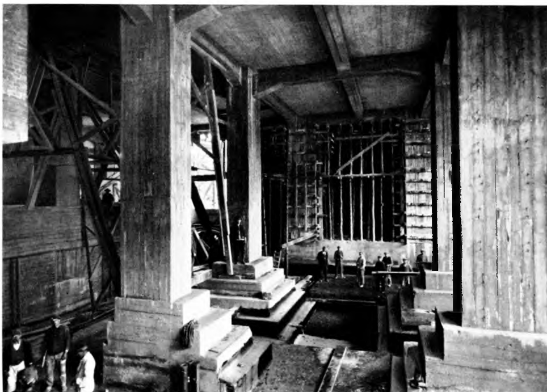
Abb. 16. Kesselraum. Blick gegen die Bunker; in der Mitte Aschfallgrube für Kessel II
