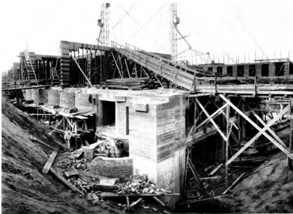
Abb. 19. Eisenbetonmauerwerk der beiden Kellergeschosse in Bauteil III; Lichtschächte in Ziegeln vorgemauert
