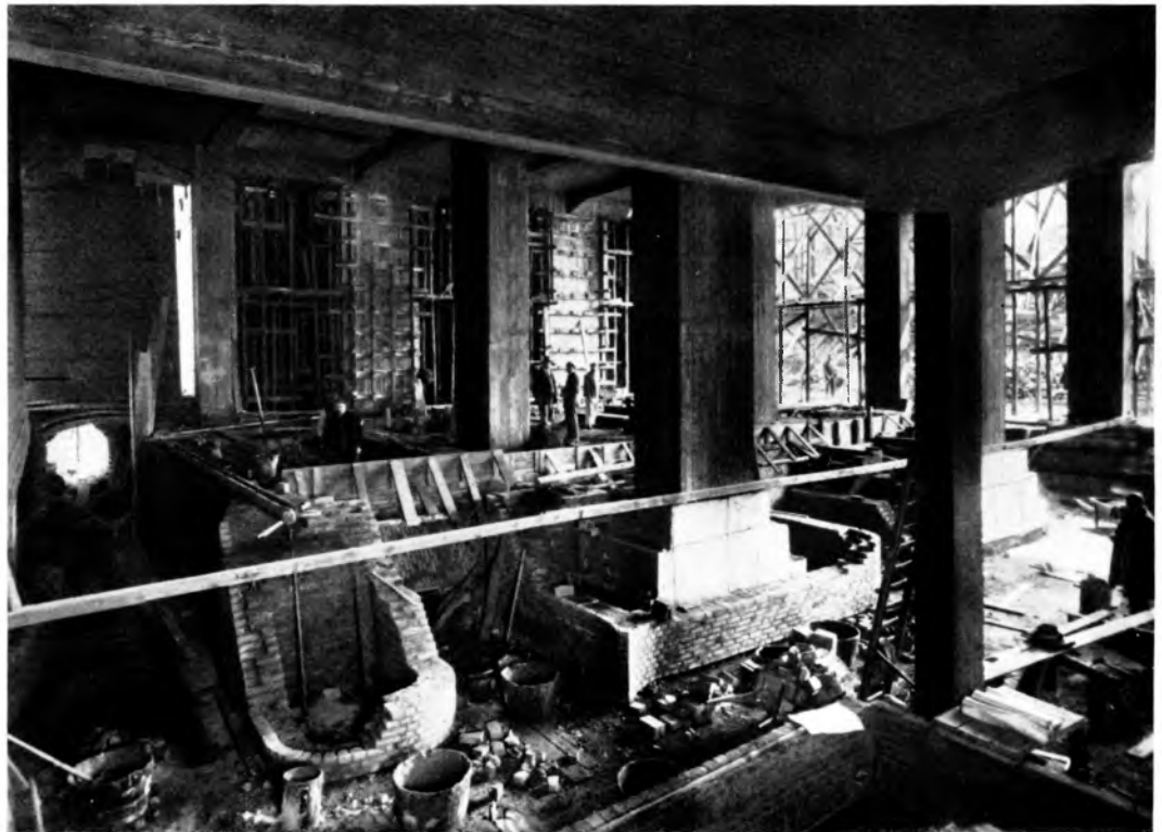
Abb. 18. Kesselraum. Aufmauern der Fuchswände; im Hintergrund die betonierten Kesseltische
