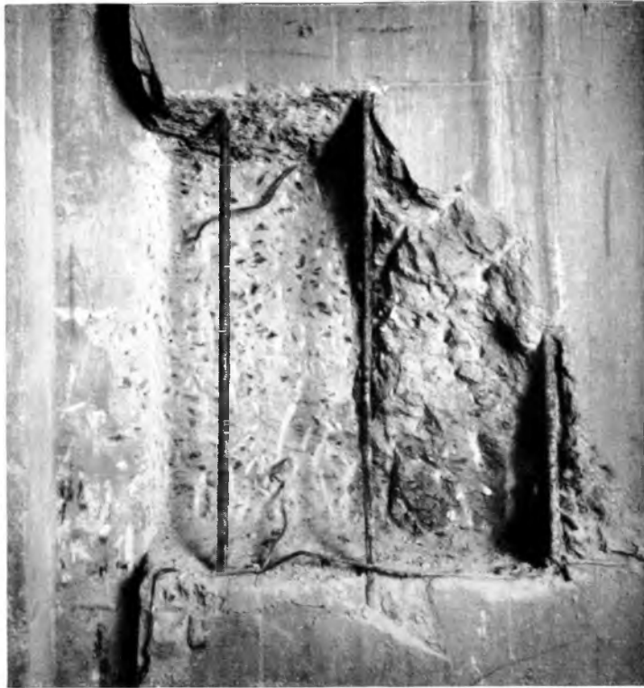
Abb. 65. Ausgestemmte Stelle an einer Gußbetonwand zur Feststellung des Betongefüges im Innern
