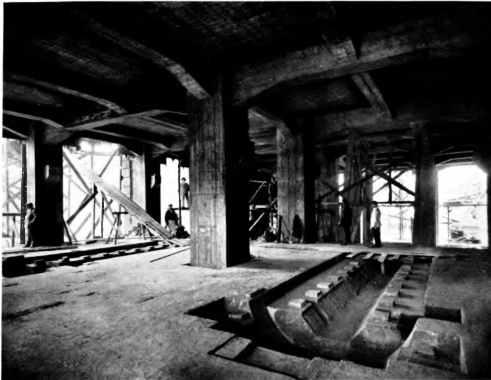
Abb. 50. Motorenraum im Rohbau; rechts Aussparungen für die Verankerung der Dieselmotoren, das Schwungrad und den Generator
