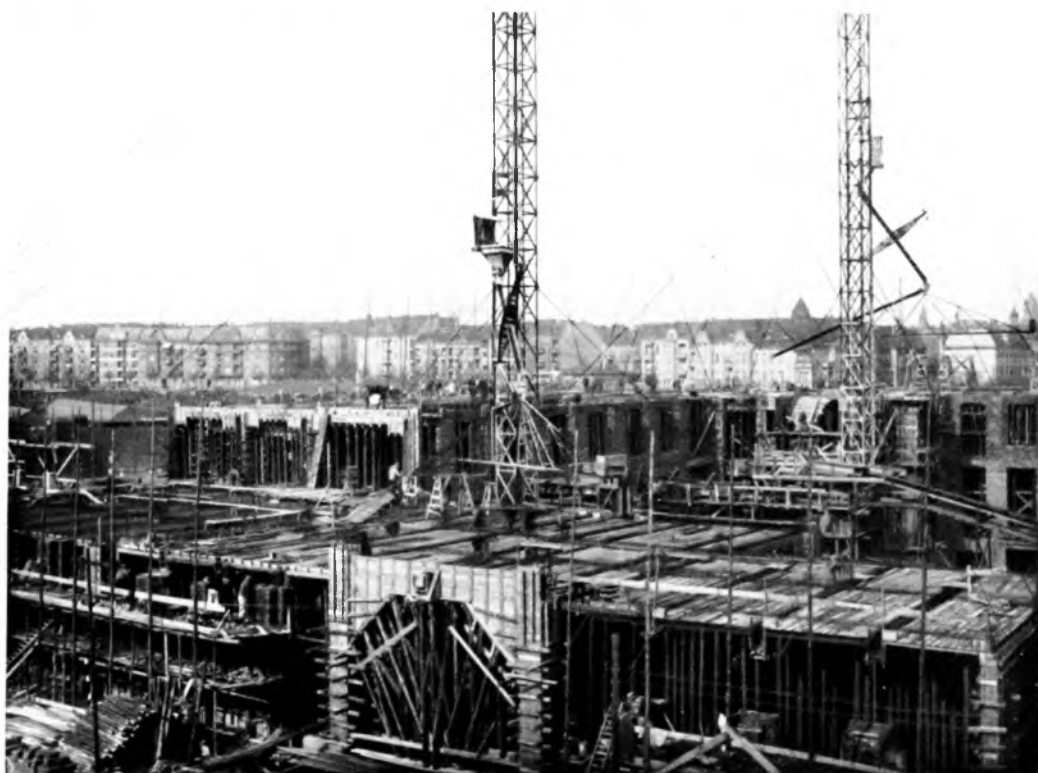
Abb. 22. Die Schalung für das Erdgeschoß des Bauteils III mit Durchfahrt ist aufgestellt. Das Flechten des Eisens und Betonieren der Decken muß zurückbleiben, bis die Aufmauerung der Außenpfeiler hochgeführt ist
