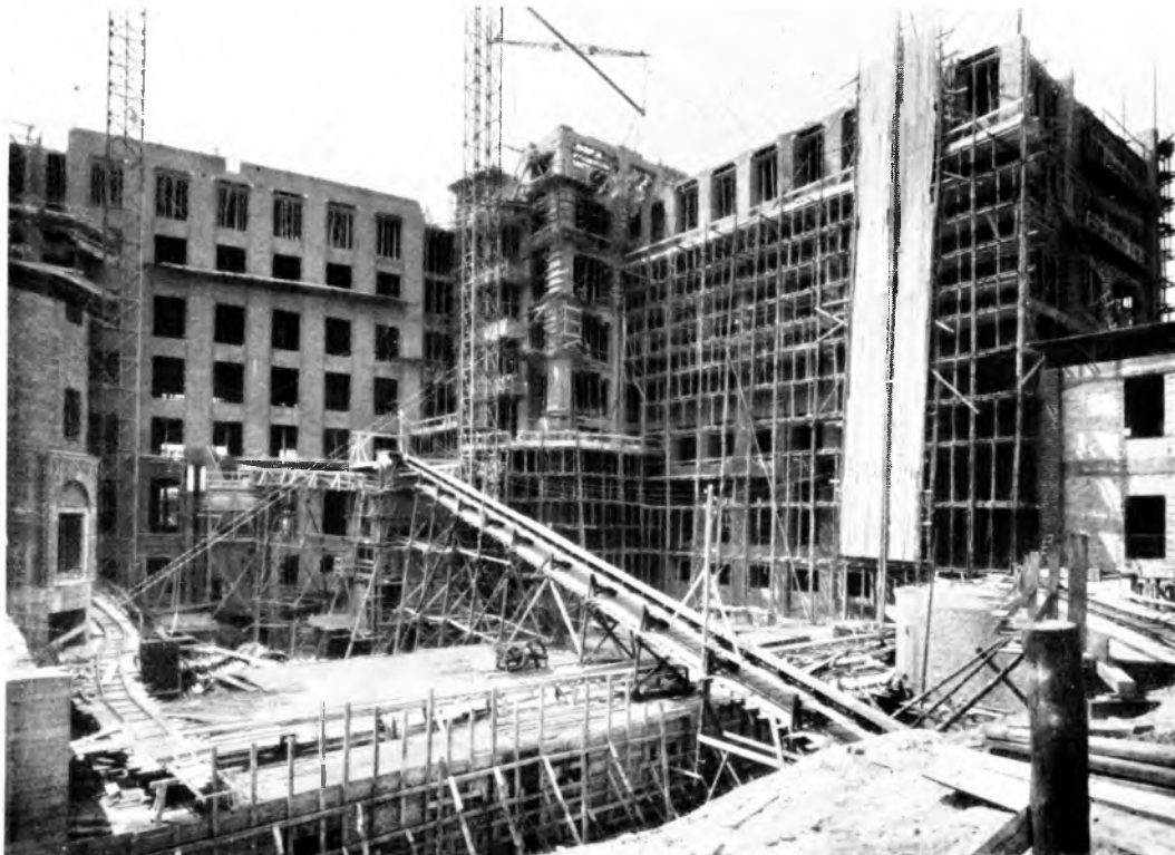
Abb. 62. Kiesförderanlage. Im Hintergrund die Holzgerüste der Aufbereitungsanlage und das Verbindungsband zwischen Turm I und Turm II
