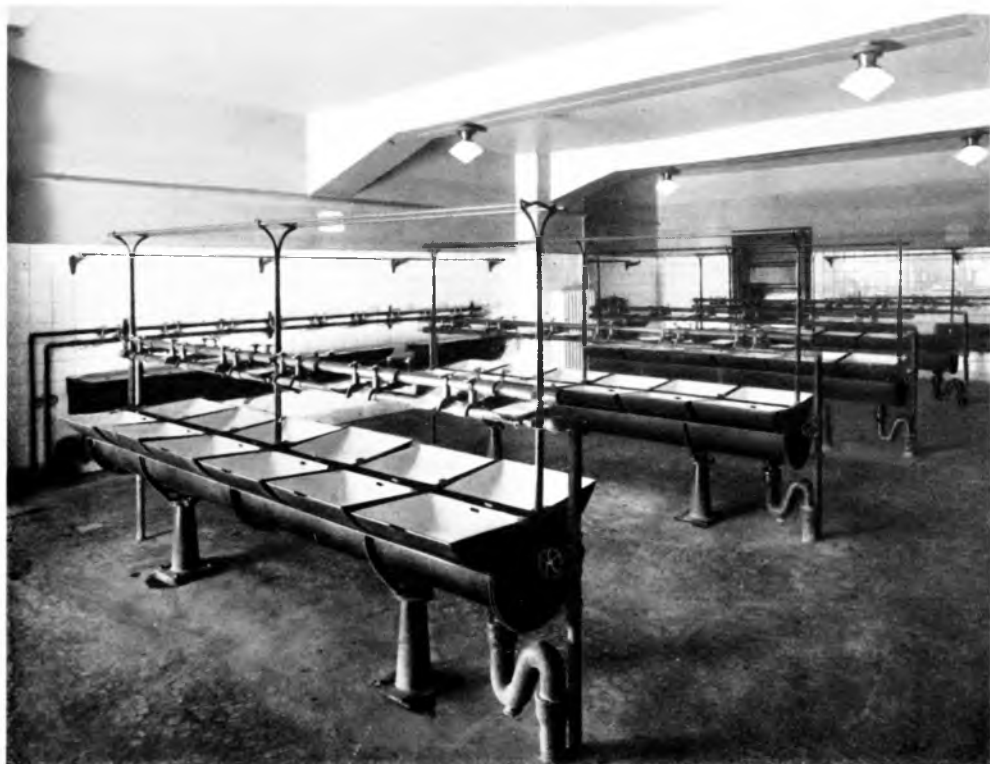
Abb. 115. Reihenwaschanlage der Männergarderoben. Wände mit glasierten Platten belegt, Fußboden Marmormosaik, Decke in gelb und rot getöntem Ölfarbenanstrich
