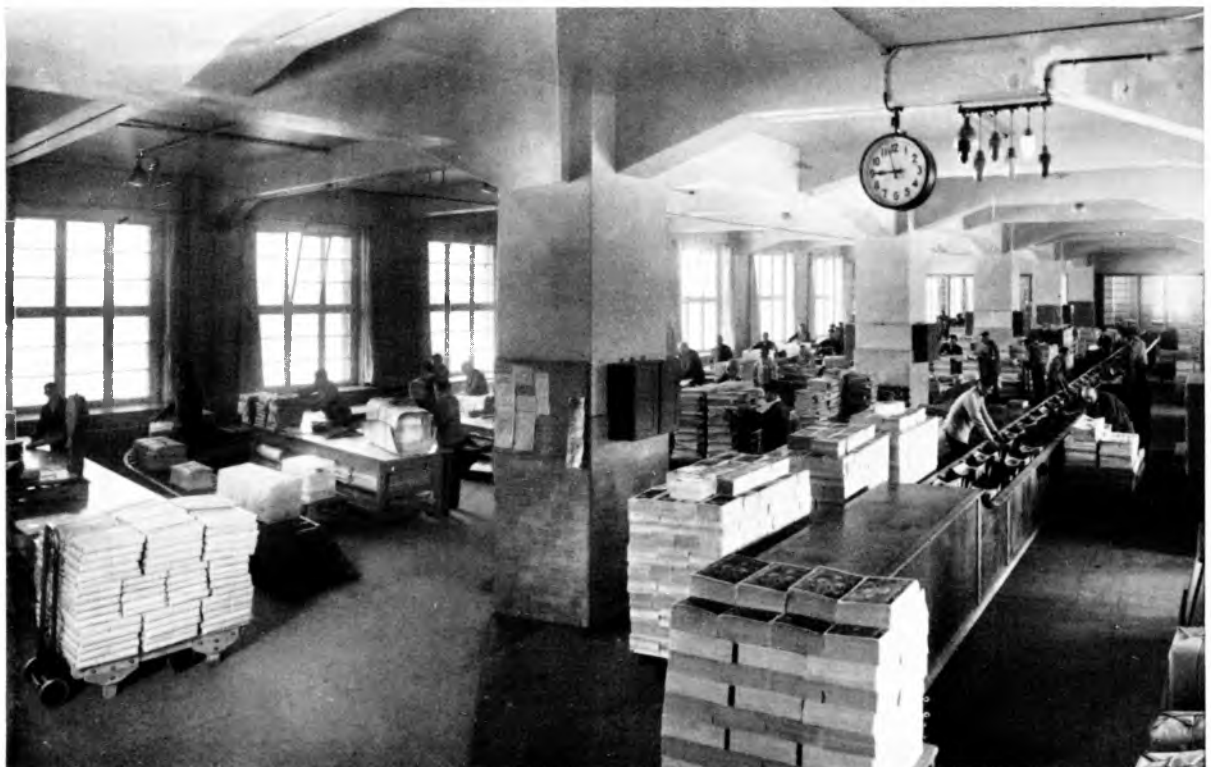
Abb. 177. Teil des Expeditionsraumes. Vorn rechts das Förderband, das die Exemplare der „Berliner Illustrierten Zeitung“ aus dem Rotationssaal in den Packraum befördert
