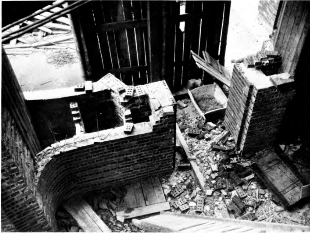
Abb. 32. Ausfachen des Eisenbetongerüstes des Turmes durch Hohlsteinmauerwerk, das mit Rundeisen bewehrt ist; Aussteifung durch gemauerte Zungen
