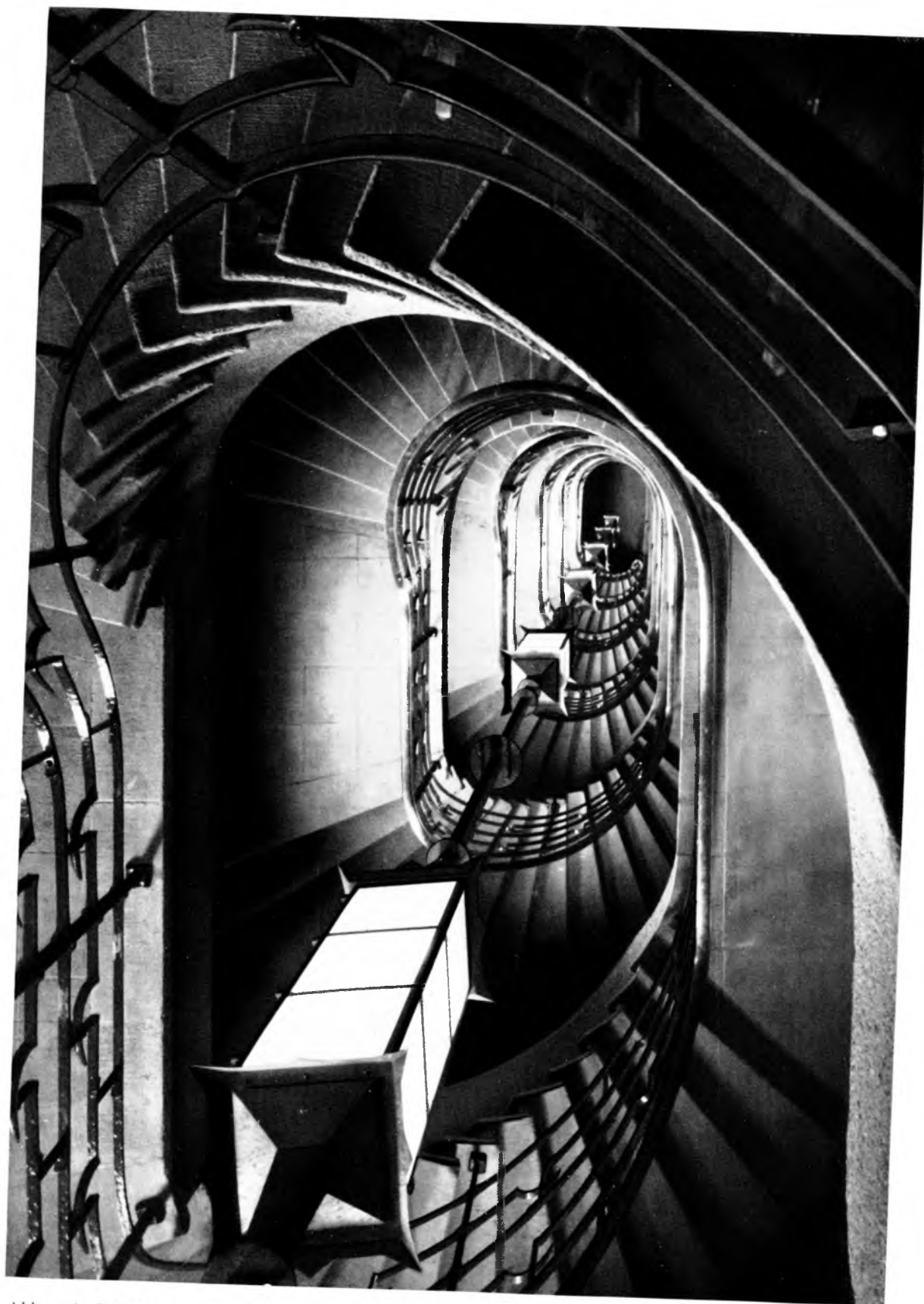
Abb. 104. Bürotreppe von oben gesehen mit durchhängenden Beleuchtungskörpern in Schmiedearbeit. Treppenbelag aus Basaltkunststein, scharriert
