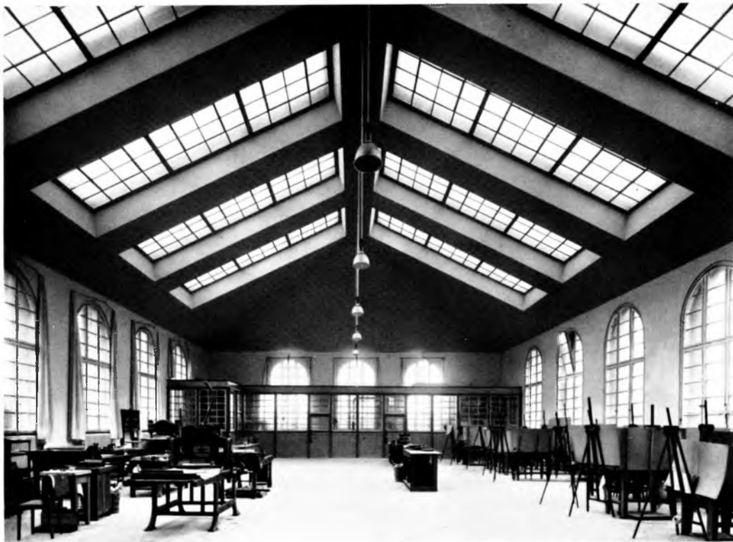
Abb. 102. Saal der Farbätzerie im VII. Stockwerk des vorgezogenen Flügels. Zahlreiche Fenster und Oberlichte beleuchten den Raum. Die Dachkonstruktion ist aus Eisenschwerk
