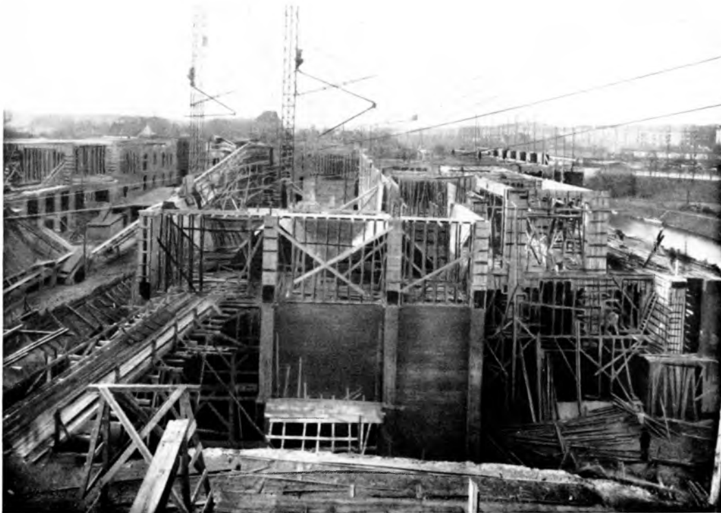
Abb. 43. Aufstellen der Schalformen für Bunkertaschen und Erdgeschoß des Bauteils VII
