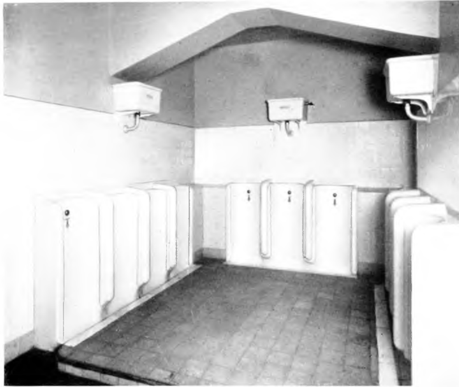
Abb. 114. Pissoiranlage der Männergarderoben. Stände aus englischer Fayence, Bodenbelag geriffelte Platten. Wände mit weißen Majolikaplatten belegt, gelber Ölfarbenanstrich der Decke
