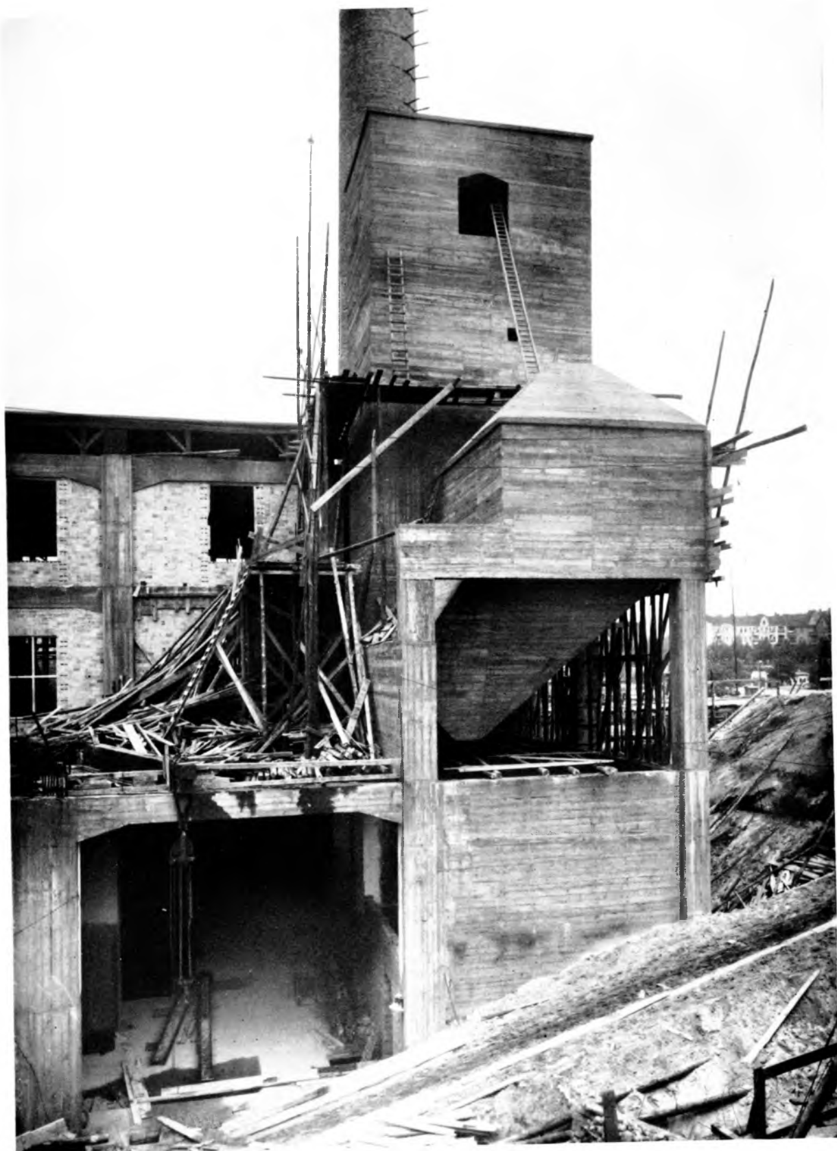
Abb. 40. Bunkeranlage — Ansicht von Süden; links unten Montageöffnung für die Kessel
