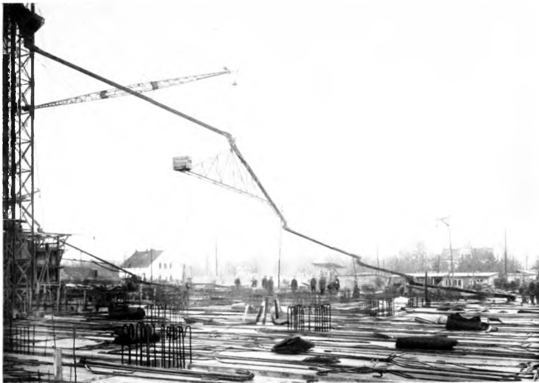
Abb. 66. Gießturm I in Tätigkeit beim Gießen der oberen Kellerdecke: Gießrinnen in größter Ausladung (45 m)
