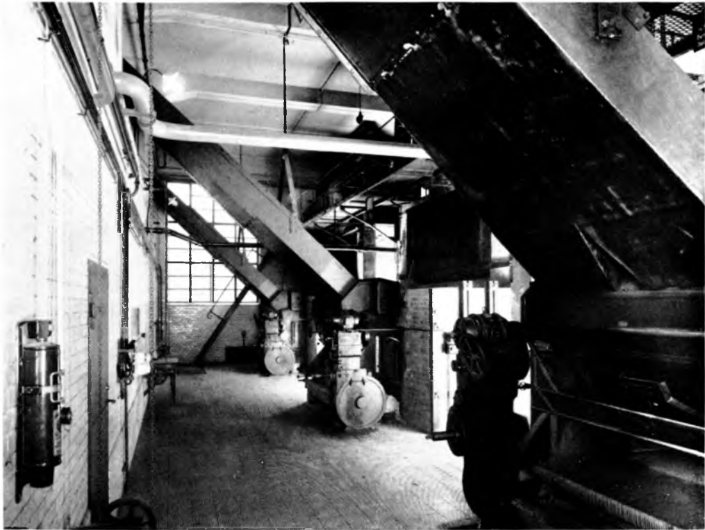
Abb. 154. Blick in das Kesselhaus. In den Kohlenrutschen fallen die Kohlen aus den Bunkern auf die motorisch angetriebenen Wanderroste
