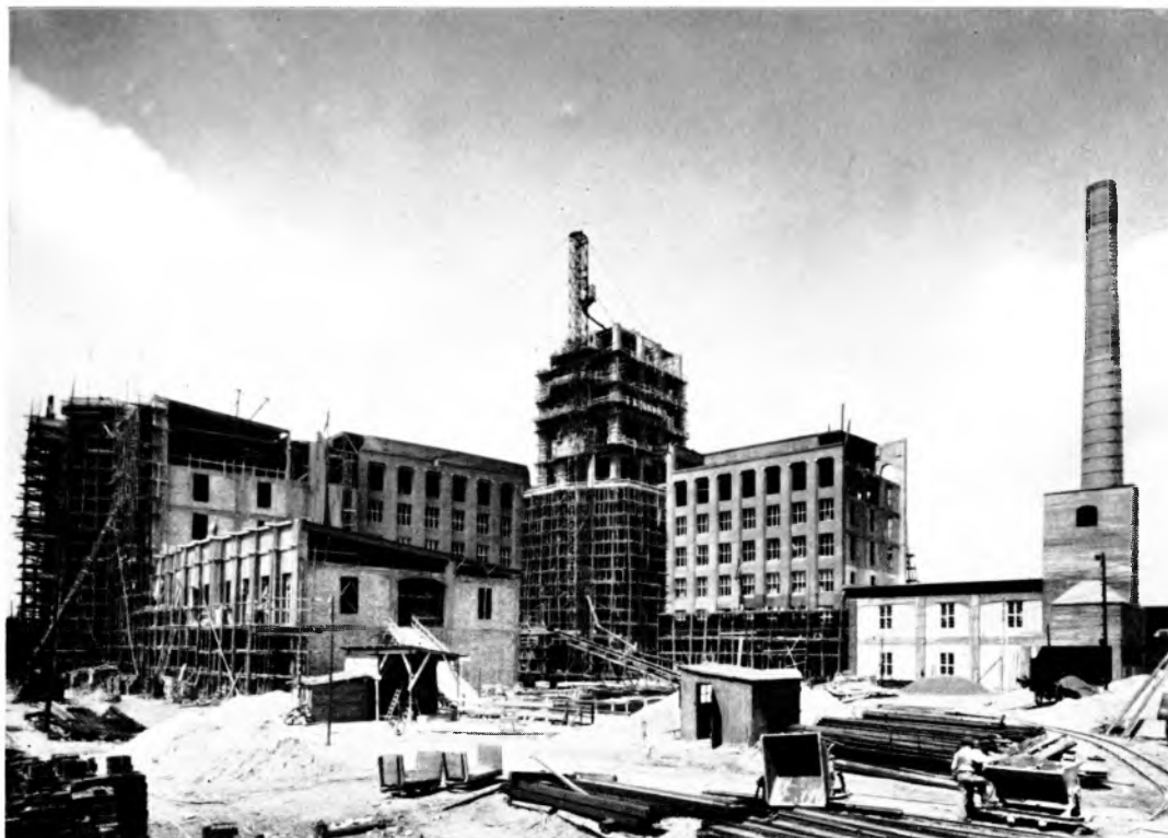
Abb. 79. Stand am 12. Juli 1926. Links vorn der zurückgelassene Flügel mit Notdach. Bauteil Ia (links), Bauteil II und IV mit fertiger Eisendachkonstruktion. Gießturm II ist abgebrochen, Turm I gießt das X. Obergeschoß des Turmes, Kohlenbunker (rechts) fertiggestellt
