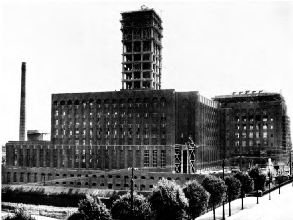
Abb. 74. Stand am 6. September 1926. Die Tragkonstruktion des Turmes ist bis auf den Turmhelm ausgeschalt. Anbringen des Kupferdaches auf den Bürohausflügel. Über dem Arbeitereingang wird die Eule aufgestellt
