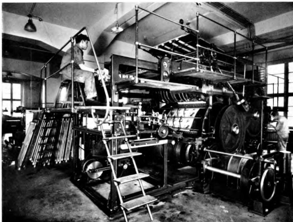
Abb. 168. Iris Vierfarben-Bogenrotationsmaschine im Schnellpressensaal. Zur Herstellung von Vierfarbendruck in einem Druckgang
