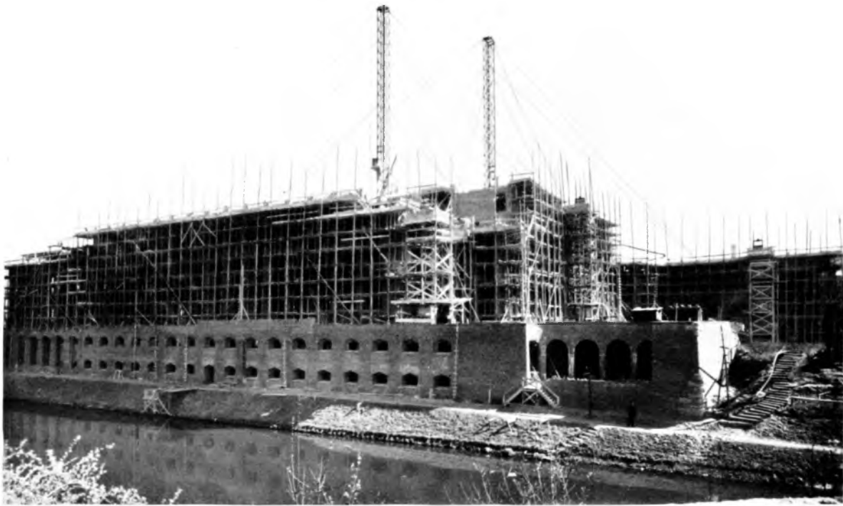
Abb. 69. Stand am 11. April 1926. Die Mauerpfeiler des III. Obergeschosses werden aufgeführt
