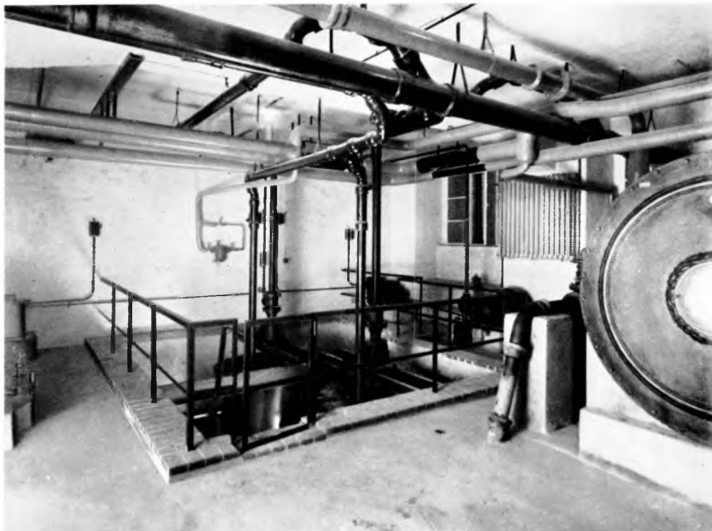
Abb. 152. Schmutzwasserhebeanlage im Tiefkeller. Zwei Mammutpumpen befördern die zugelaufenen Schmutzwasser in die höher gelegenen städtischen Schmutzwasserableitungen
