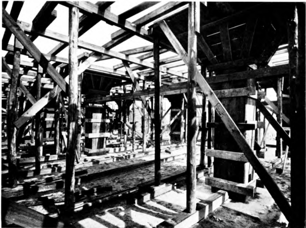
Abb. 48. Einschalung der Pilzdecke über der Kantine
