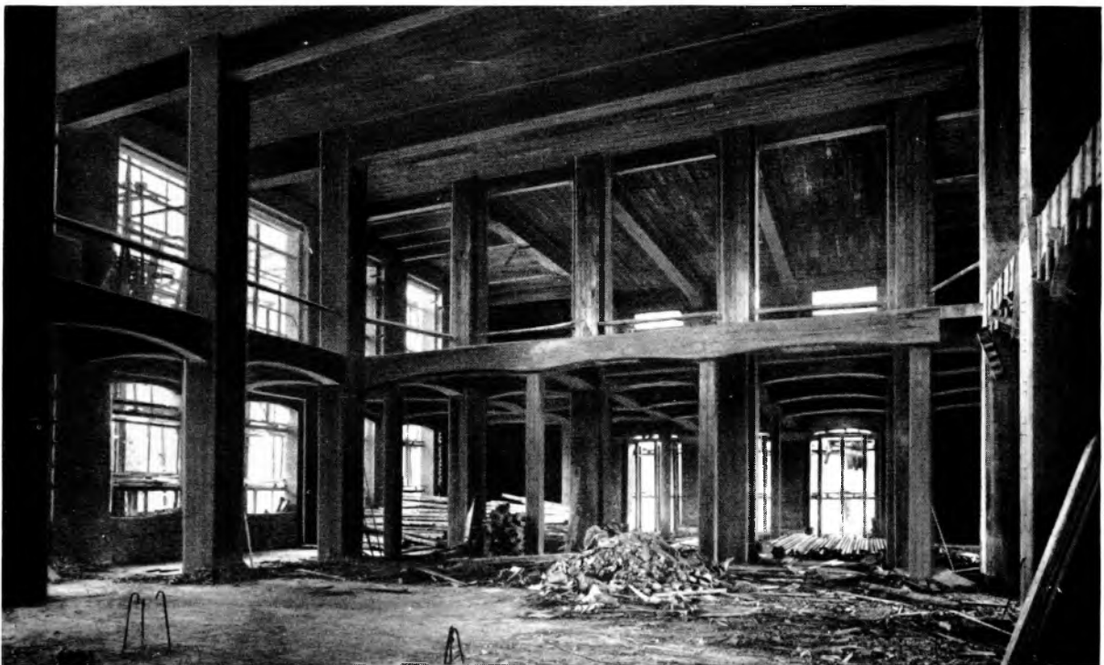
Abb. 38. Eingangshalle des vorgezogenen Flügels im Rohbau; Eisenbetonkonstruktion ausgeschalt. Sie wirkt leicht wegen der niedrig gehaltenen Deckenbalken
