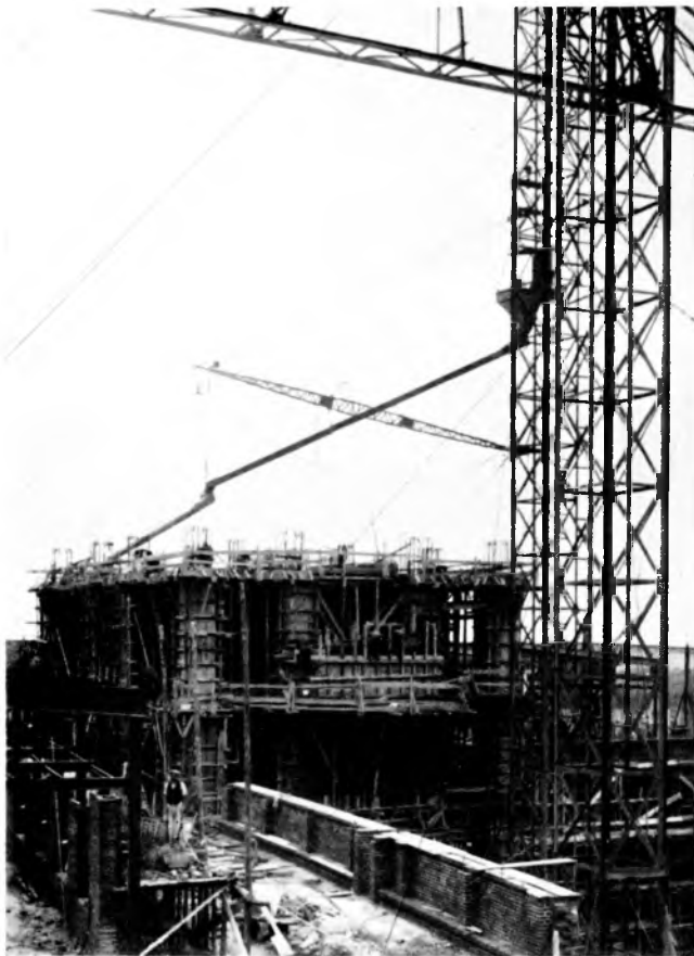
Abb. 35. Betonieren des VII. Obergeschosses im Turm mit Gießturm I
