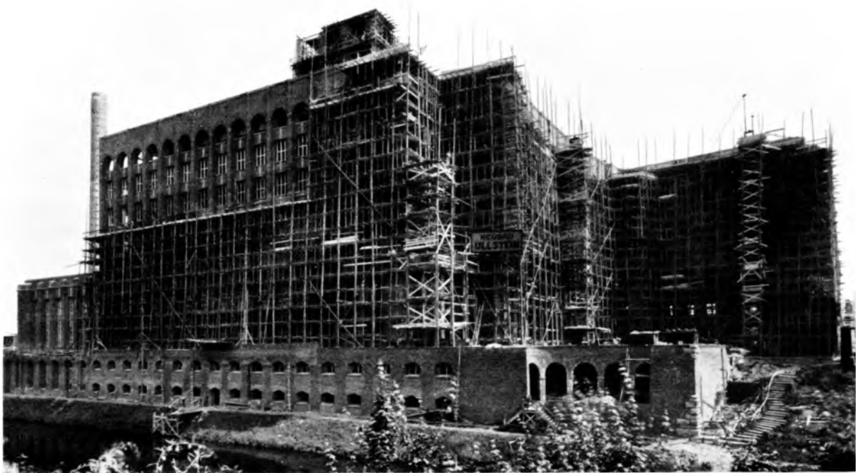
Abb. 73. Stand am 12. Juli 1926. Der Rohbau ist bis zum Hauptgesims fertiggestellt; desgleichen der 62 m hohe Schornstein; links der liegengebliebene Flügel mit Notdach. Die Schauseiten werden abgerüstet und abgeseuert, das VII. und VIII. Obergeschoß (Turm) geschalt
