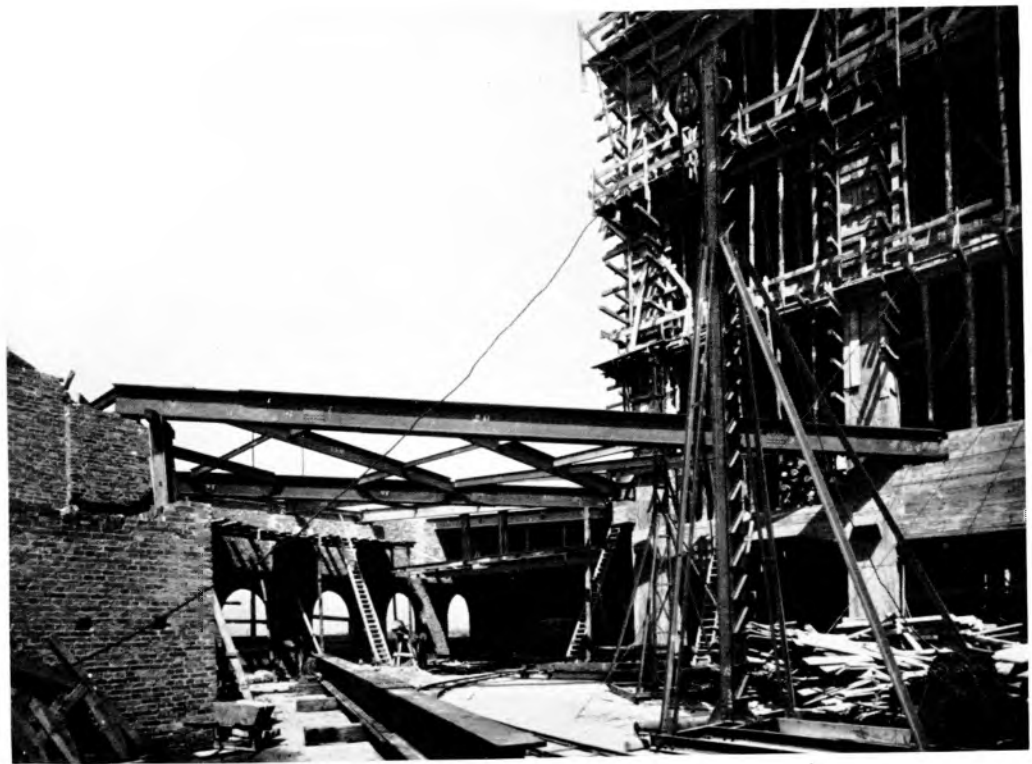
Abb. 53. Aufstellen der eisernen Dachkonstruktion für Bauteil II am Turm
