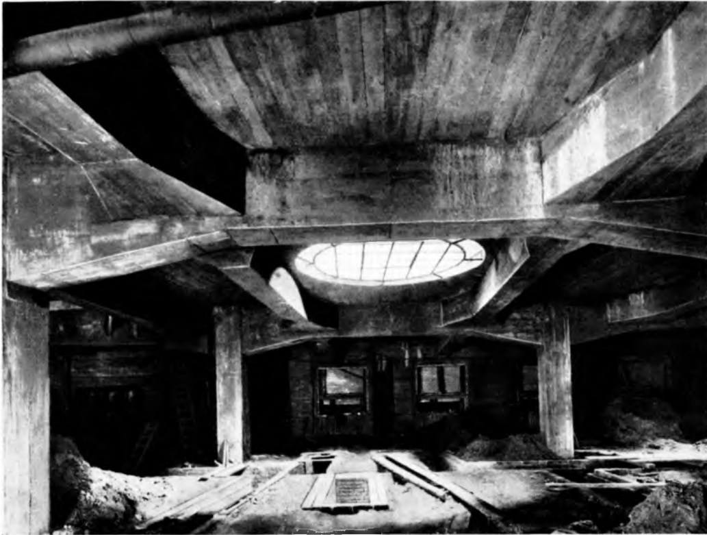
Abb. 46. Balkendecke über der Küche. Die Balken sind am Auflager verbreitert zur Verringerung der erforderlichen Konstruktionshöhe
