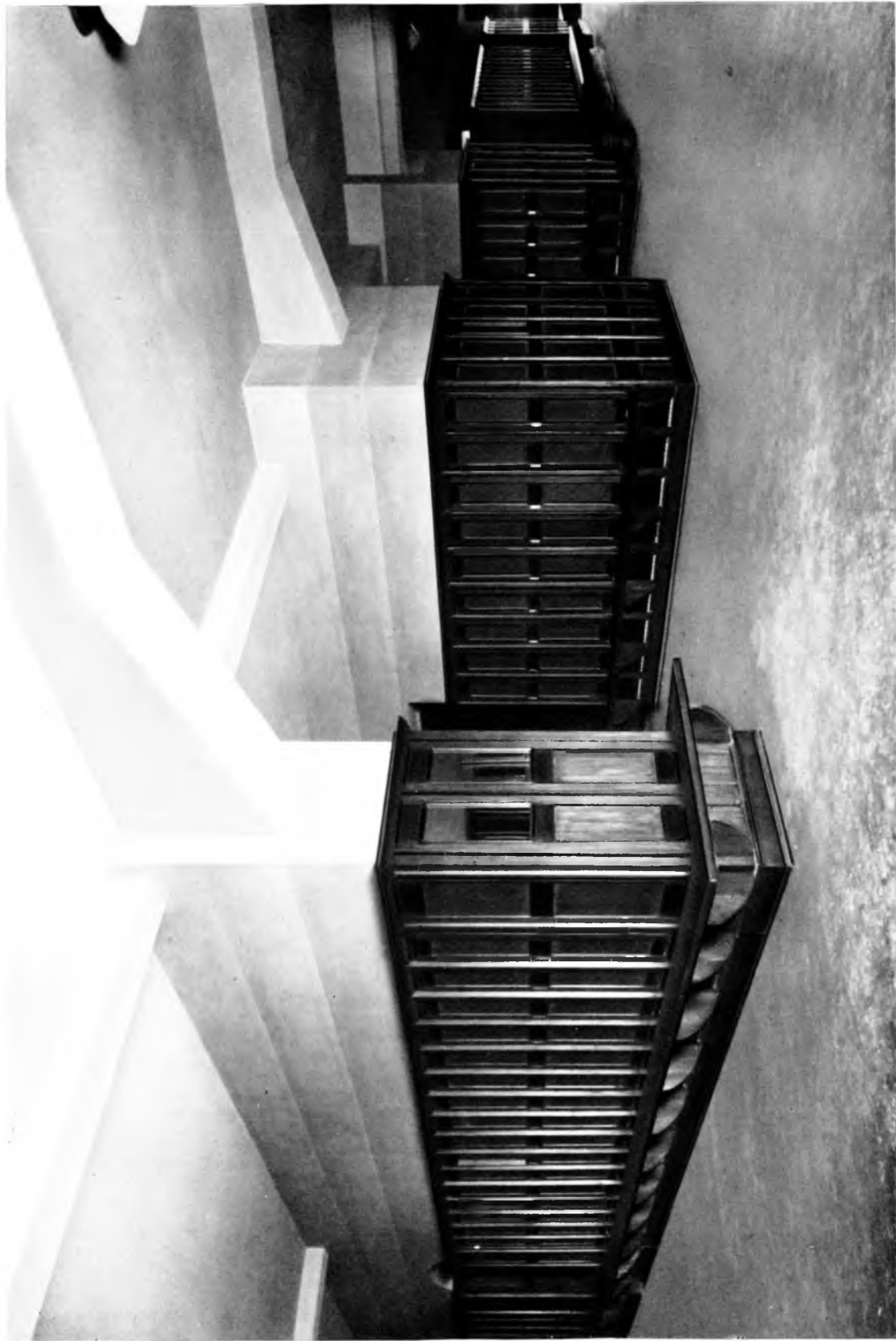
Abb. 113. Frauengarderobe. Eingebaute Schränke aus dunkelgebeiztem Kiefernholz, Linoleumschutz am Sockel, Marmormosaikfußboden
