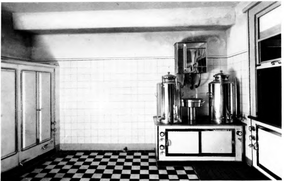
Abb. 106. Kaffee- und Teeküche. Links Wärmeschrank für mitgebrachtes Essen der Angestellten, rechts Kaffeebereiter und Ausgabe. Alle Ausgabetische werden mit Dampf gewärmt
