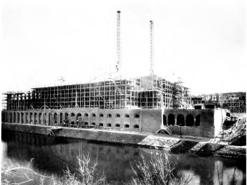
Abb. 68. Stand am 20. März 1926. Die Decke über dem I. Obergeschoß ist fertiggestellt
