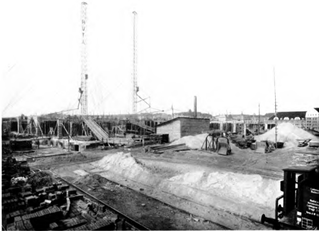
Abb. 77. Stand am 27. Februar 1926. Ansicht von SO, der Ullstein-Straße aus. Stützen und Decke des Erdgeschosses werden geschalt
