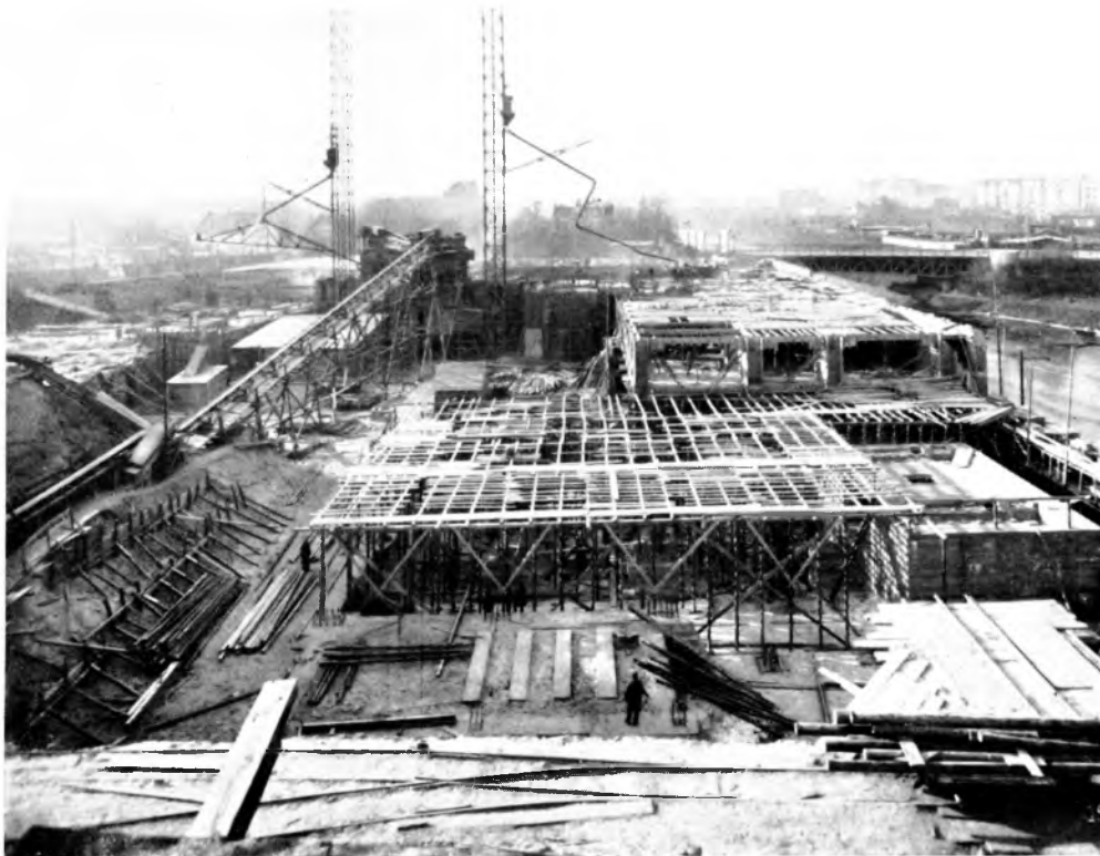
Abb. 20. Beginn des Schalungsbaues für das Kellergeschoß des Bauteils VII; rechts vorn der ausgeschaltete Sockel für die Dieselmotoren
