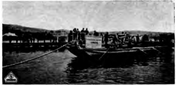
Abb. 20. 50 kV-Drehstrom-Ölkabel-Verlegung im Zürichersee.
