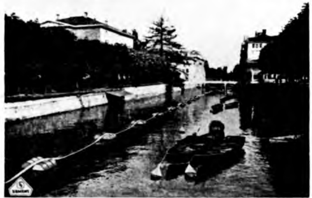
Abb. 21. 50 kV-Drehstrom-Ölkabel-Verlegung, Kabel (32 t) auf Benzinfässern im Schanzengraben (Zürich).
