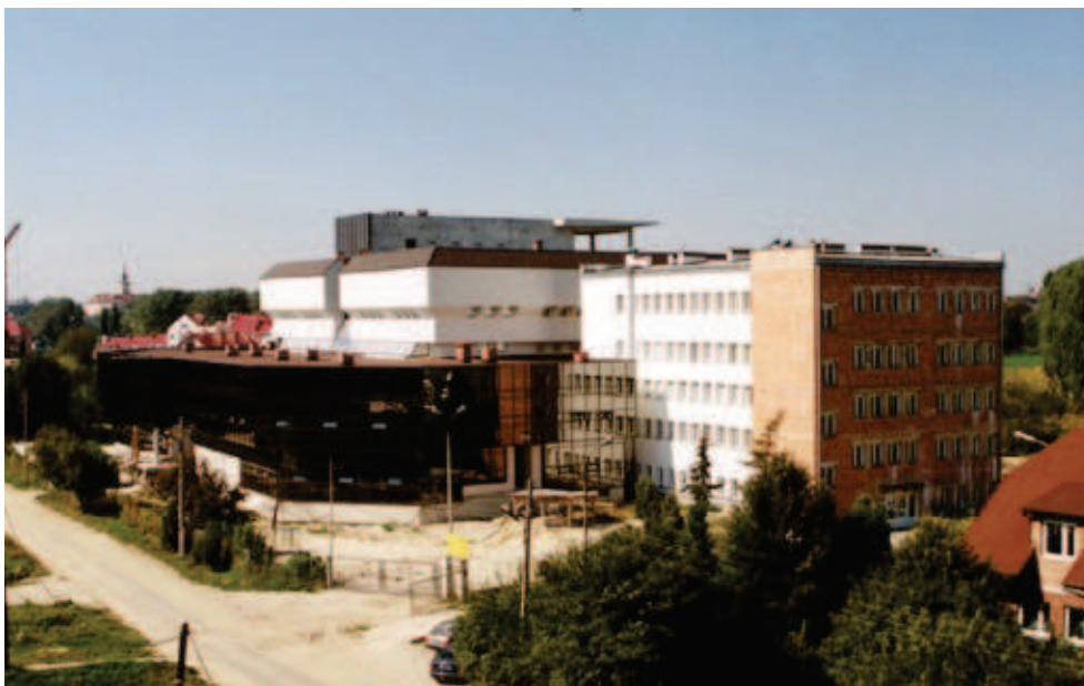
Budowa Regionalnej Biblioteki Akademickiej, wrzesień 1998
