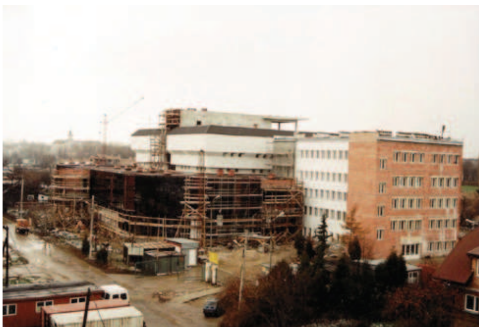
Budowa Regionalnej Biblioteki Akademickiej, czerwiec 1997
