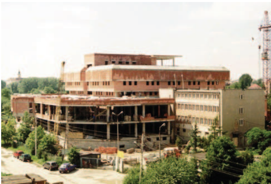
Budowa Regionalnej Biblioteki Akademickiej, kwiecień 1996
