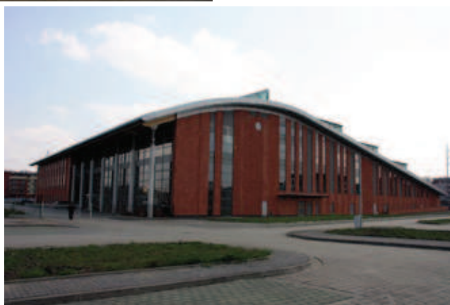
Widok budynku od strony pół- nocno-zachodniej
