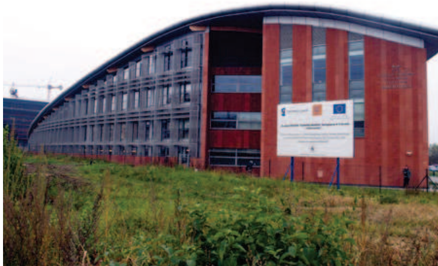
Widok budynku od strony południowo-wschodniej
