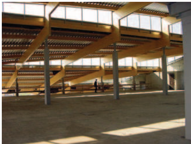
Konstrukcja dachu budynku
