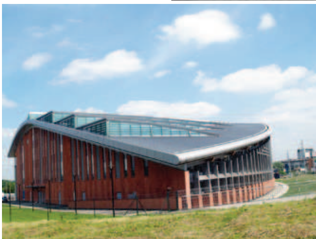
Widok budynku od strony południowo-zachodniej
