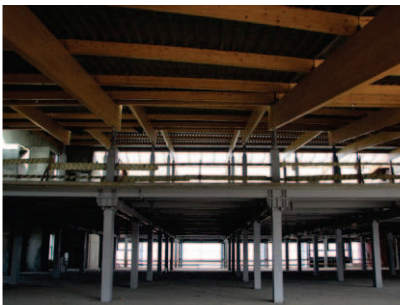
Fot. 3. Konstrukcja stalowa budynku – stan surowy*
