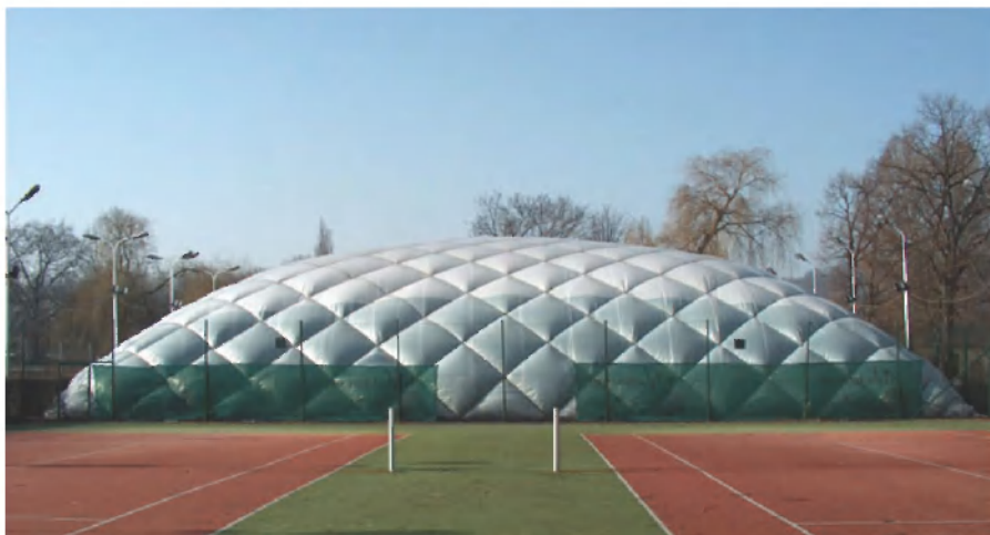
Rys. 138. Budowla pneumatyczna, hala sportowa MM Sopot – 2 korty tenisowe 33x32 m
