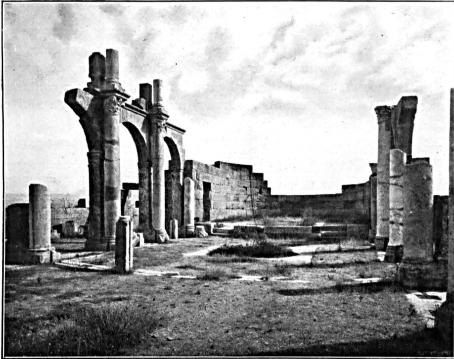
Basilique de Tébessa.
