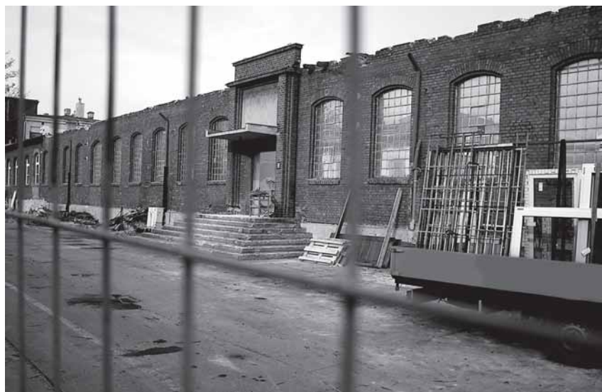
Z budynku pozostały tylko zewnętrzne mury
