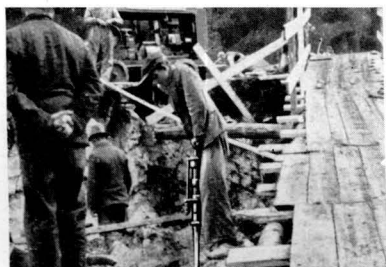
Abb. 86 Fundamentaushub m. FMA-Aufbruchhammer Tabelle 24 Nr. 1—3, 21—35
