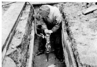
Abb. 87 Gesteinbohren mit FMA-Bohrhammer
