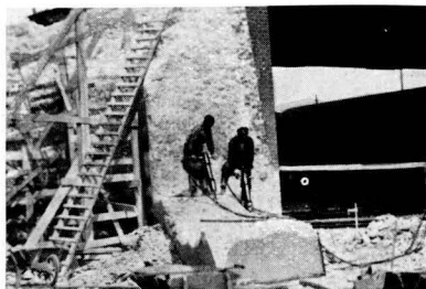
Abb. 85 Brückenabbruch mit FMA-Aufbruchhammer Tabelle 24 Nr. 1—3, 31—35
