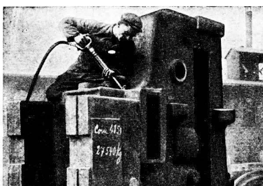
Abb. 77 Gußputzen mit FMA-Meißelhammer Tabelle 23 Nr. 1—24
