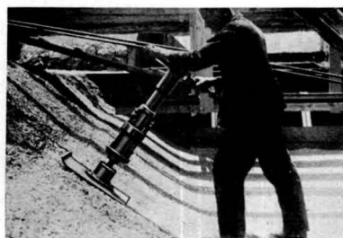
Abb. 81 Böschungstampfen mit FMA-Stampfer Tabelle 24 Nr. 4, 1—3
