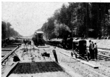
Abb. 78 Straßenbau mit fahrbarem FMA-Kompressor Seite 176
