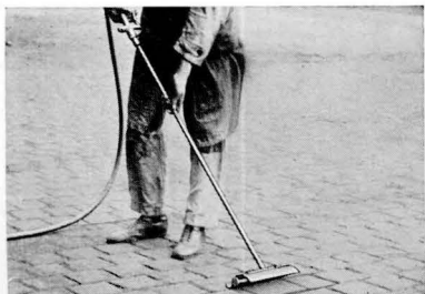
Abb. 108 Fugen ausblasen
