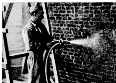
Abb. 107 Torkretverfahren Auftragen von Zement auf Mauerwerk
