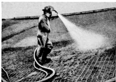
Abb. 106 Torkretverfahren Auftragen von Zement auf Flächen
