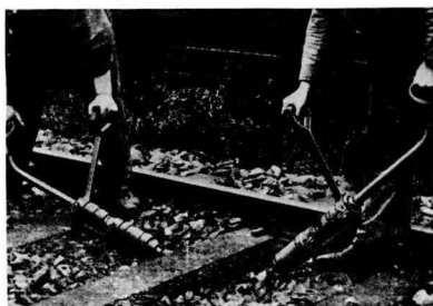
Abb. 102 Gleisstopfen
