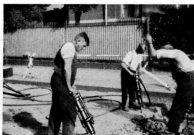
Abb. 80 Betonaufbrechen mit FMA-Aufbruchhammer Tabelle 24 Nr. 1—3
