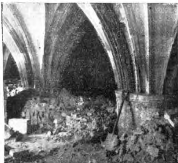
Fig. 2. Ratusz w Szczecinie w obecnym okresie odbudowy. Filary pięknego gotyckiego sklepienia w piwnicach w czasie odgruzowania.
