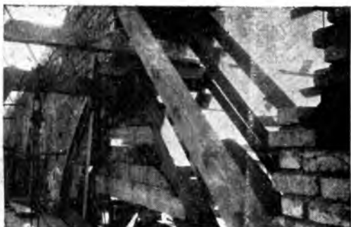
Fig. 28. Zabezpieczanie rusztowaniami i stemplami drewnianymi zagrożonych otworów.
