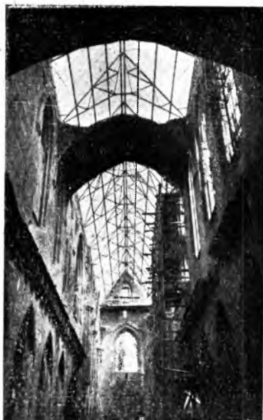
Fig. 19 i 20. Z lewej strony widok nawy głównej przed odbudową, — z prawej strony widok tejże nawy po ustawieniu nowej konstrukcji dachowej z lekkich profili stalowych.
