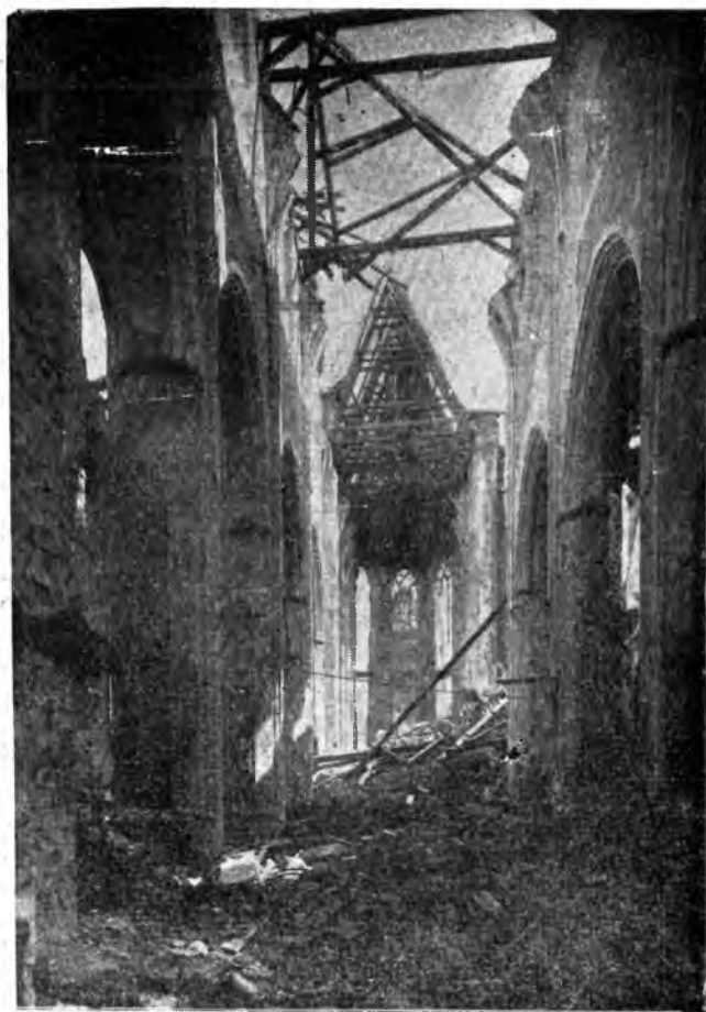
Fig. 4. Kościół Św. Wincentego we Wrocławiu w ruinie. Obraz większości kościołów po nawale wojennej. Kościół zostanie zabezpieczony przed dalszym zniszczeniem przez uzupełnienie wyrw w ścianach, wzniesienie konstrukcji dachowej i ułożenie pokrycia dachówkowego.
