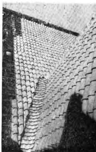
Fig. 32, 33 i 34. Układanie dachówki na odbudowanej konstrukcji dachowej na kościele Św. Krzyża we Wrocławiu. Szczególnie godne uwagi jest wzorowe ułożenie koszuw w dachówce (robota wykonywana najczęściej w „partacki sposób“ w blasze.
