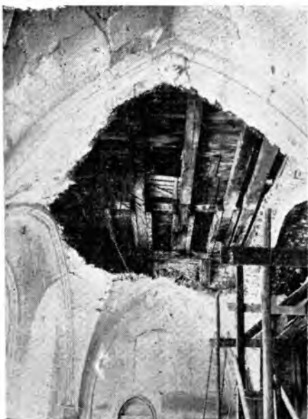
Fig. 40 i 41. Odbudowa sklepienia nad Salą Książęcą w Ratuszu Wrocławskim (fig. 39). Na krążynach ułożono pozbierane części kamiennych żeber i następnie przystąpiono do wysklepiania uszkodzonych pól sklepiennych.
