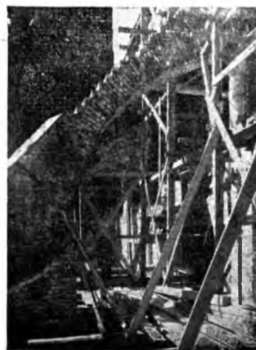
Fig. 29. Odbudowa łuków przyporowych na krążynach.
