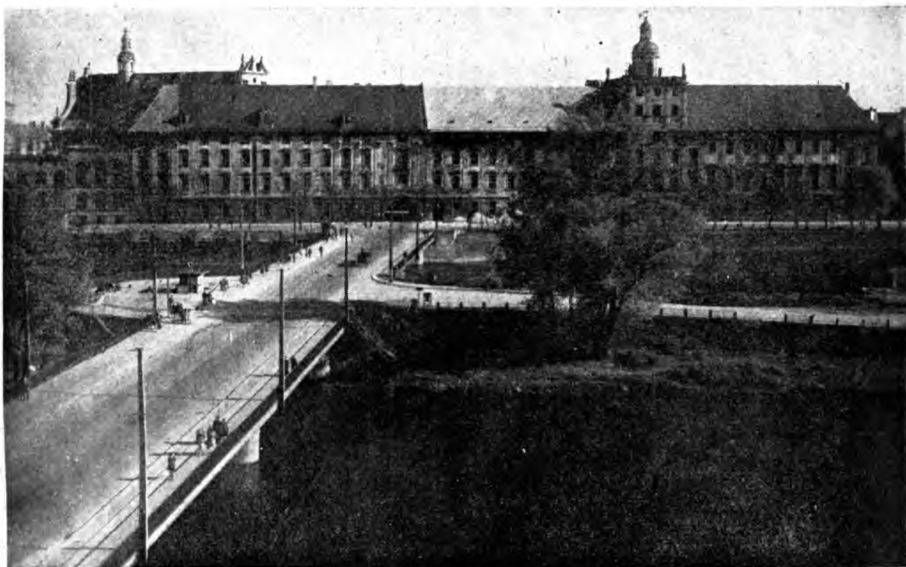
Fig. 8. Barokowy gmach Uniwersytetu Wrocławskiego po odbudowie (widać część nowego pokrycia dachowego, odbudowaną wieżę i stojące jeszcze rusztowania w części środkowej). Z lewej strony za gmachem Uniwersytetu Kościół Św. Macieja.
