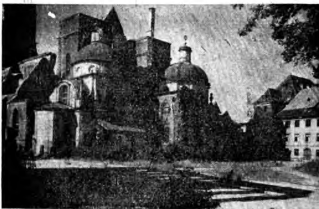
Fig. 6. Wschodnia część Katedry Wrocławskiej. Renesansowe i barokowe kaplice dobudowane do gotyckiej Katedry przypominają dobudowę kaplic w ciągu wieków do Katedry Wawelskiej.
