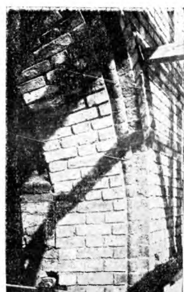
Fig. 21 i 22. Fragmenty odbudowy sklepień i otworów okiennych w Katedrze. Z prawej strony łęk okienny ceglany z profilowaniem ze specjalnych cegieł. Tego rodzaju roboty murarskie wymagają wybitnie uzdolnionych murarzy. Przy odbudowie Katedry Wrocławskiej pracuje znakomita grupa murarzy-specjalistów, autochtonów spod Opola.
