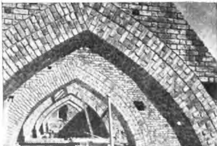
Fig. 30 i 31. Widok boczny konstrukcji stalowej nowego dachu nad Katedrą Wrocławską, — z prawej strony perspektywa nowoodbudowanych łuków przyporowych, wykonanych wzorowo przez murarzy opolskich. Zwraca uwagę świetne wykonanie zworników ostrołukowych sklepień.
