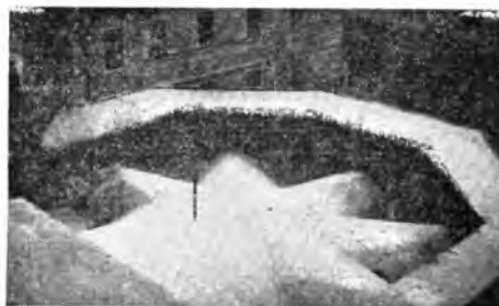
Fig. 35 i 36. Kościół św. Macieja we Wrocławiu w odbudowie. Na zdjęciu z prawej strony widoczne zabezpieczenie i wzmocnienie sklepień ceglanych jednej z kaplic przez pokrycie sklepień warstwą betonu z gładzią cementową. Tego rodzaju sposób zabezpieczenia sklepień posiada dwie zasadnicze zalety: w okresie oczekiwania na nową konstrukcję dachową, którą niezawsze można natychmiast wykonać, choćby ze względów budżetowych, chroni się w ten sposób wnętrze kościoła przed rujnującym wpływem opadów, wreszcie wzmocnienie konstrukcji betonem wpływa bardzo dodatnio na całość, często silnie naruszonych murów.
