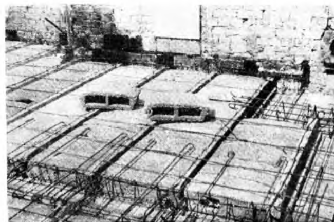
Fig. 5. Strop na kolonii Dulsberg w Hamburgu z pustaków gruzowych.
