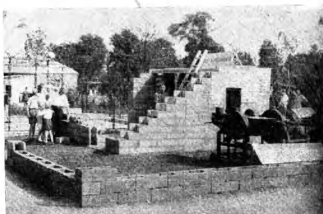
Fig. 4. Domek wykonany całkowicie z gruzu. Na pierwszym planie maszyna do produkcji pustaków ściennych.
