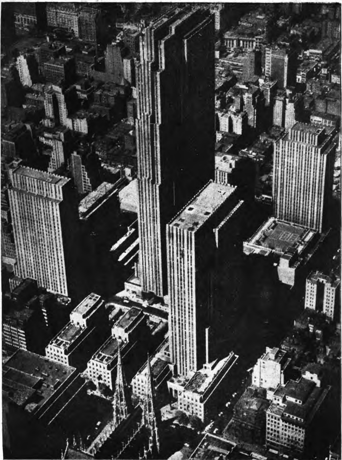
Fig. 1. New York, Manhattan, Rockefeller Center. Ukończony w 1940 r. zespół biurowców dla 25.000 urzędników. Kombinacja budynków wysokich i niskich umożliwia należyte oświetlenie; dominantą jest 70-piętrowy budynek R. C. A. (Radio Corporation of America). Podziemny dowóz towarów; podziemne garaże; podziemne przejścia łączą poszczególne budynki. Rockefeller Center jest jedyną swojego rodzaju grupą drapaczy, planowaną jednocześnie i jednolicie. („Built in USA“ New York 1944). Ilustracja do artykułu z następnej strony.
