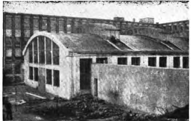
Fig. 10. Hala fabryczna po odbudowie.
