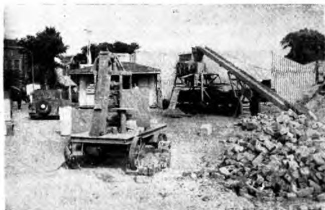
Fig. 2. Maszyny do czyszczenia cegieł z rozbiórki.
