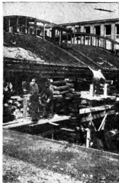
Fig. 3. Widok z boku hali podczas odbudowy. Widoczne są klatki na których spoczywa podnoszony dźwigami wieńiec konstrukcji żelbetowej.
