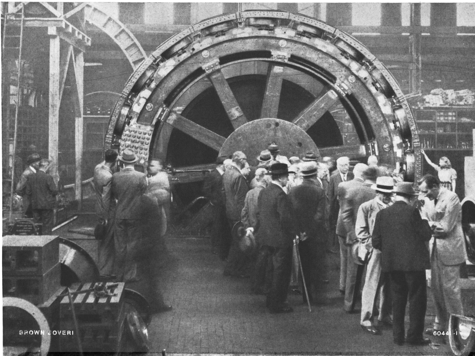
Fig. 2. — Vue de la roue polaire sans coffrage après l'essai de survitesse.
