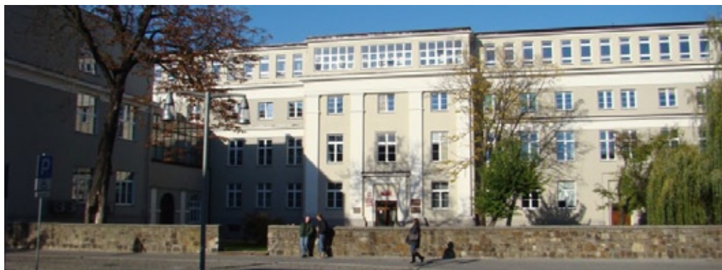
Stary gmach Biblioteki przy ulicy Leśnej 16
