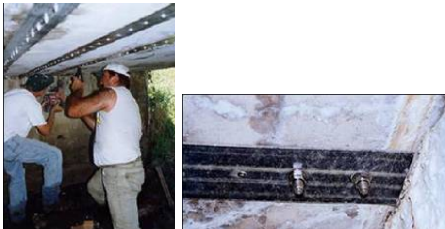
Rys. 4.3. Aplikacja kompozytów przy użyciu mechanicznych łączników (fib, 2001)
