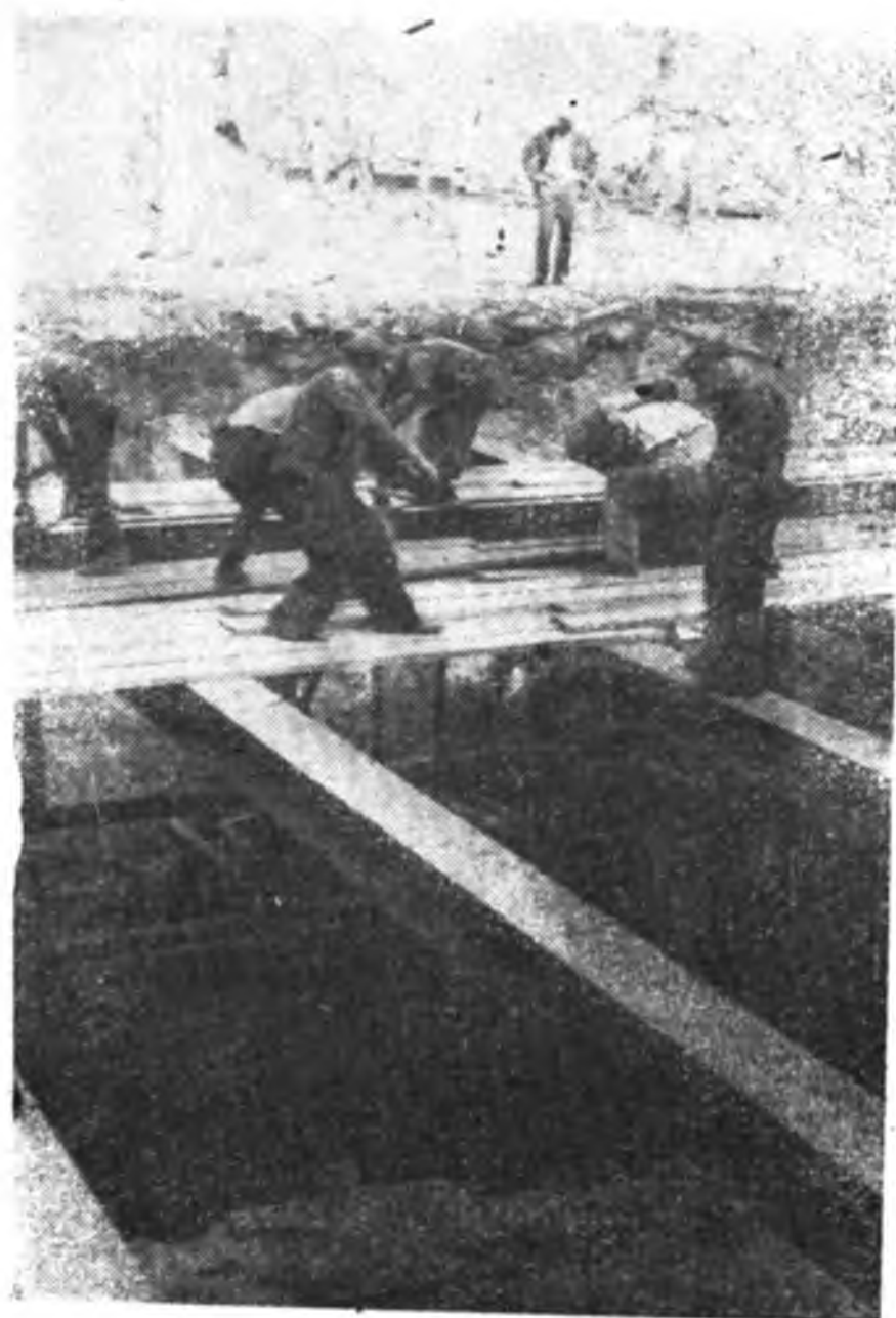
Rys. 4. Moment podnoszenia płyty.
