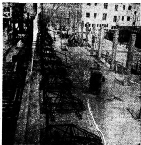
Fig. 6. Widok ściany zewnętrznej z ustawionymi rusztowaniami.
