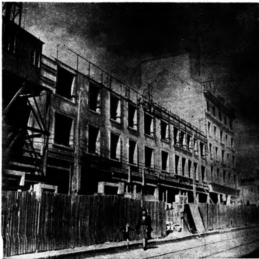
Fig. 2. Widok części budującego się bloku w zniszczonym centrum Orleanu. W głębi widoczny wykończony segment zabudowy. Na średnim planie widoczne rusztowania stalowe Croizat-Angeli, służące do betonowania ścian zewnętrznych; pionowe rurowe słupki rusztowań są umocowane w imadłach do obramowań okiennych ze sztucznego kamienia, do tych słupków umocowane są przy pomocy złączek po-
