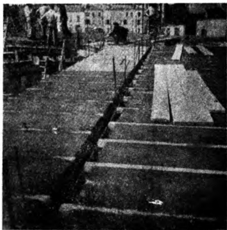
Fig. 12. Zmontowane partie stropu zostały już wypełnione betonem, pozostał jeszcze do zabetonowania wysokowartościowym betonem podciąg główny.
