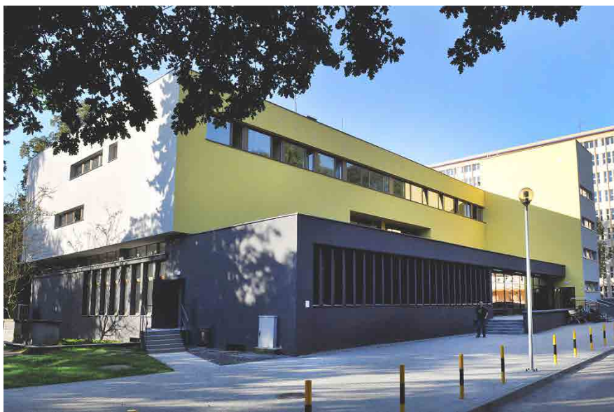
Fot 16. Widok budynku Biblioteki Głównej GUMed po modernizacji (sierpień 2016 r., fot. Z. Wszeborowski)
