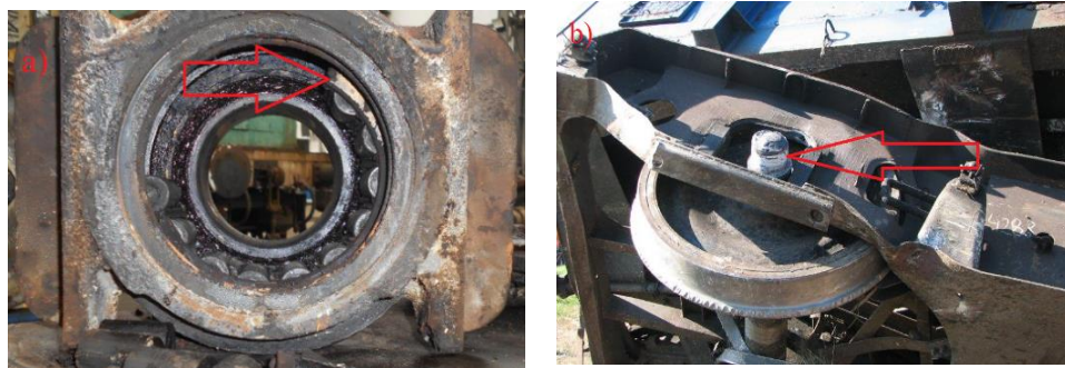
Rys. 3. Skutki uszkodzenia łożyska osiowego:
