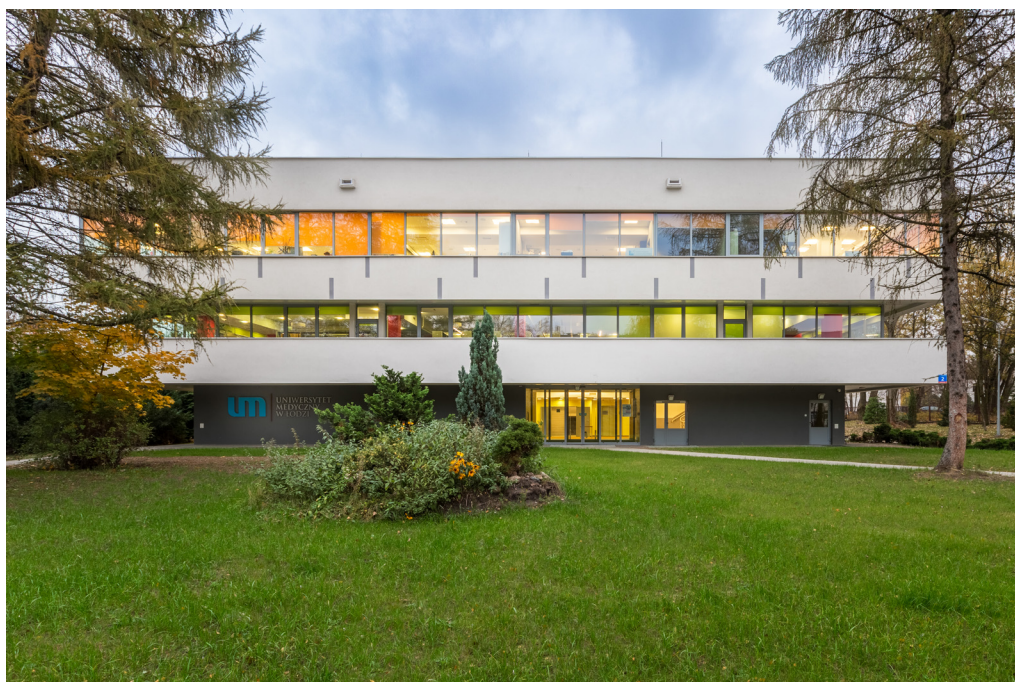
Budynek Strefy Wiedzy i Innowacji Uniwersytetu Medycznego w Łodzi po modernizacji
