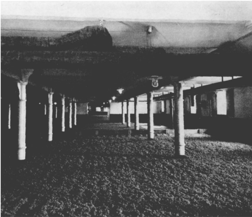
Abb. 42. Malztenne mit Kühlanlage (System Borsig)
