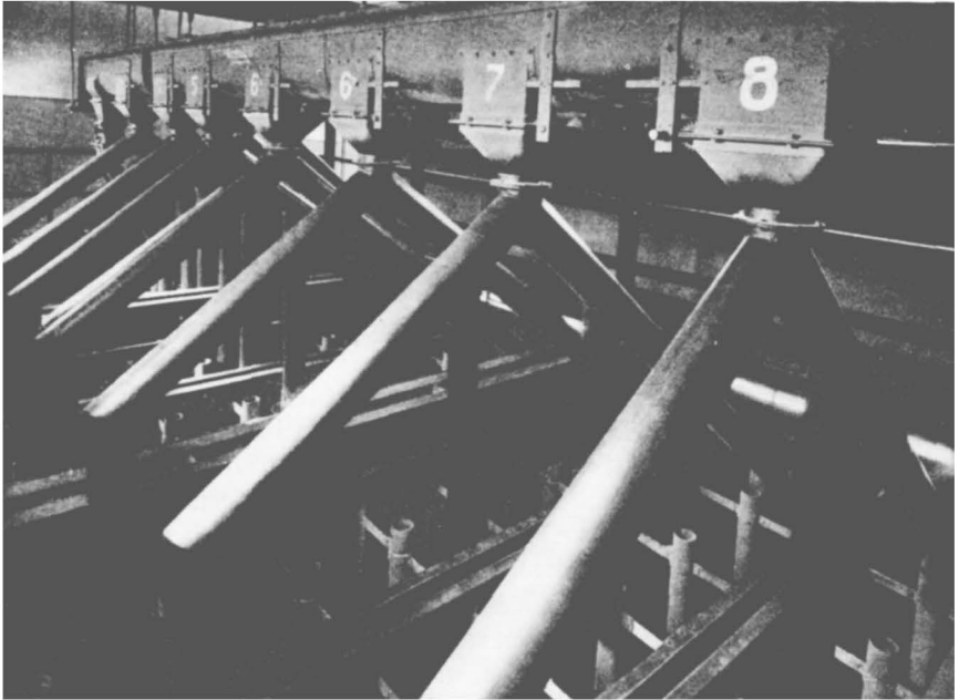
Abb. 105. Malzkühlanlage aus schmalen freistehenden Eisenbehältern
