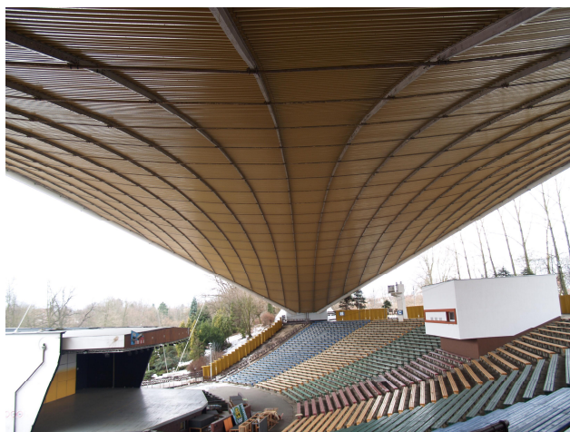
Rys. 1. Przekrycie wiszące jako zadaszenie amfiteatru
