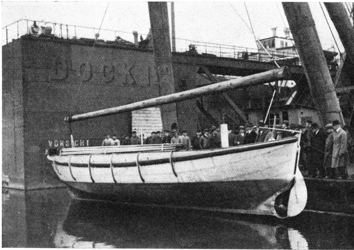
Abb. 11. Das mit einem Eisengewicht entsprechend 145 Personen belastete Boot wird in den an den Enden angebrachten Haken hängend durch einen Kran aus dem Wasser gehoben.
