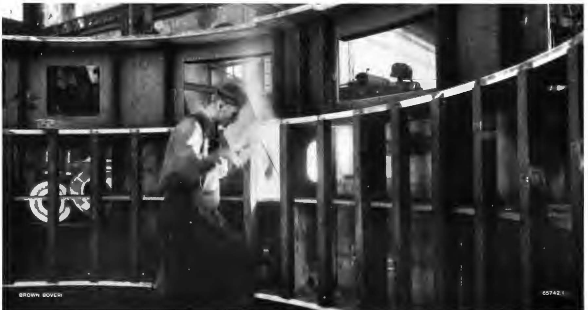
Abb. 7 Statorgehäuse eines Vertikalgenerators beim Anschweißen der Tragleisten für die trapezförmigen Statorblechkeile
