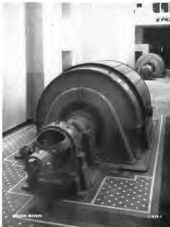
Abb. 5 — Zwei Dreiphasen-Phasenkompensatoren von je 18 000 kVA, 15 000 V, 1000 U/min, 50 Hz in der Unterstation Cero de La Plata der Unión Eléctrica Madrileña (Spanien)
