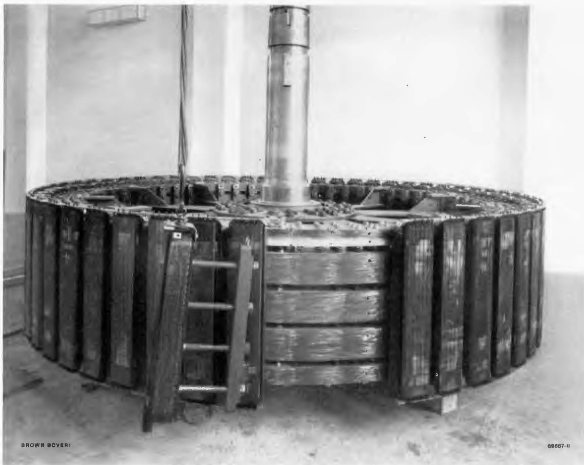
Abb. 2 — Kettenrotor des 107 torigen Vertikal-Generators von 15 MVA während der Montage im Kraftwerk Kymmene (Finnland)
