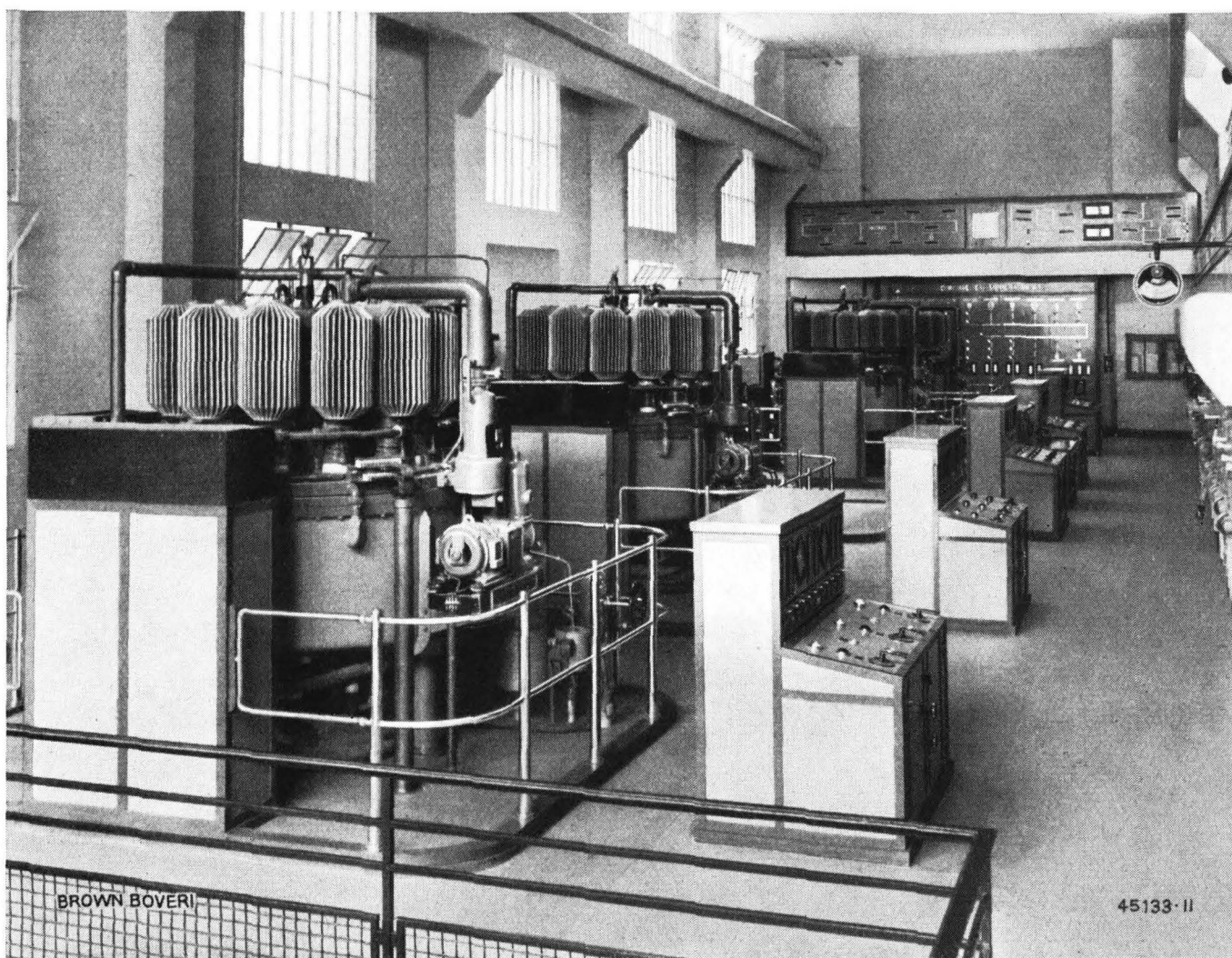
Abb. 32. — Chemin de fer Métropolitain, Paris. Unterstation Laborde. Vier Mutatorgruppen mit je 3000 kW, 615 V.
