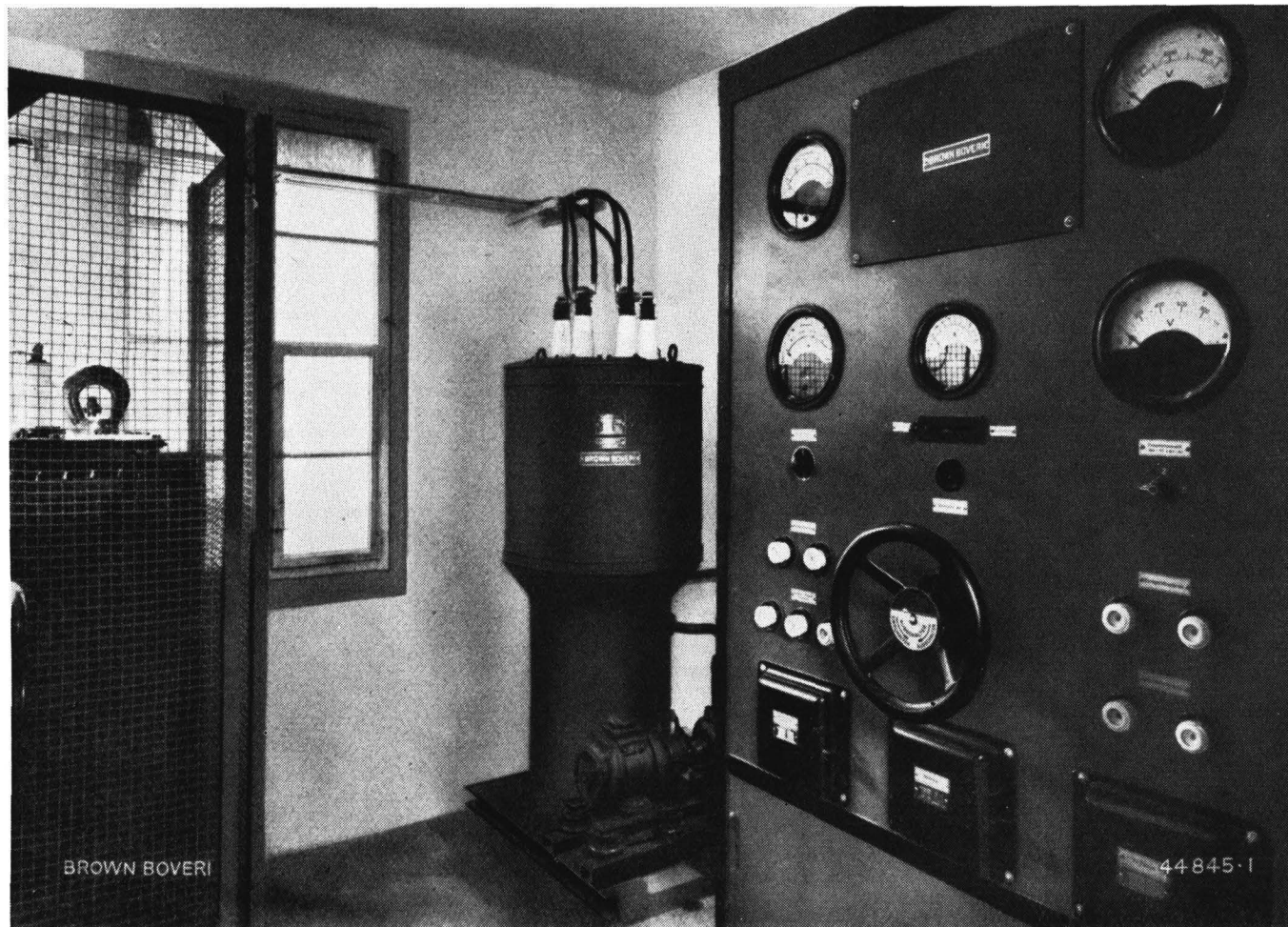
Abb. 29. — Aarau-Schöftland-Bahn. Klein-Mutatorgruppe 300 A, 700–800 V.
