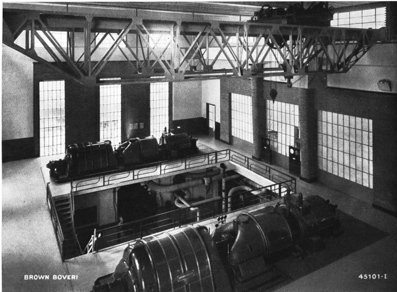
Abb. 7. — Zwei Zweizylinder-Kondensations-Turbogruppen. Turbinen je 14 000 kW, 36 kg/cm 2 abs, 425° C mit dreistufiger Speisewasservorwärmung durch Entnahmedampf.
