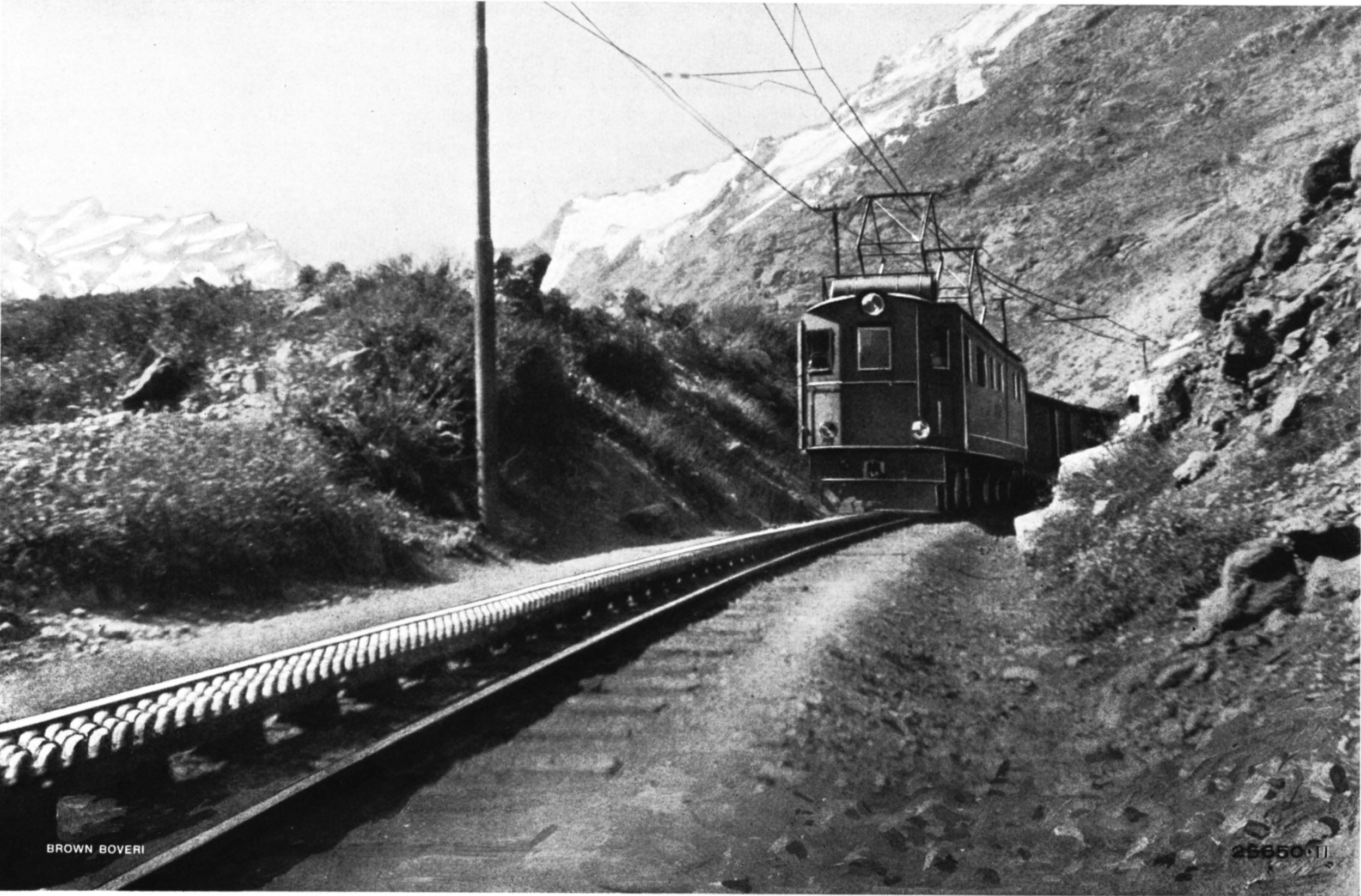
ZUG DER CHILIAN TRANSANDINE RAILWAY COMPANY IN DEN ANDEN. Kombinierte Zahnrad- und Adhäsionslokomotive Type 1 C + C 1 von 6 × 235 kW Stundenleistung, 3000 V Gleichstrom.
