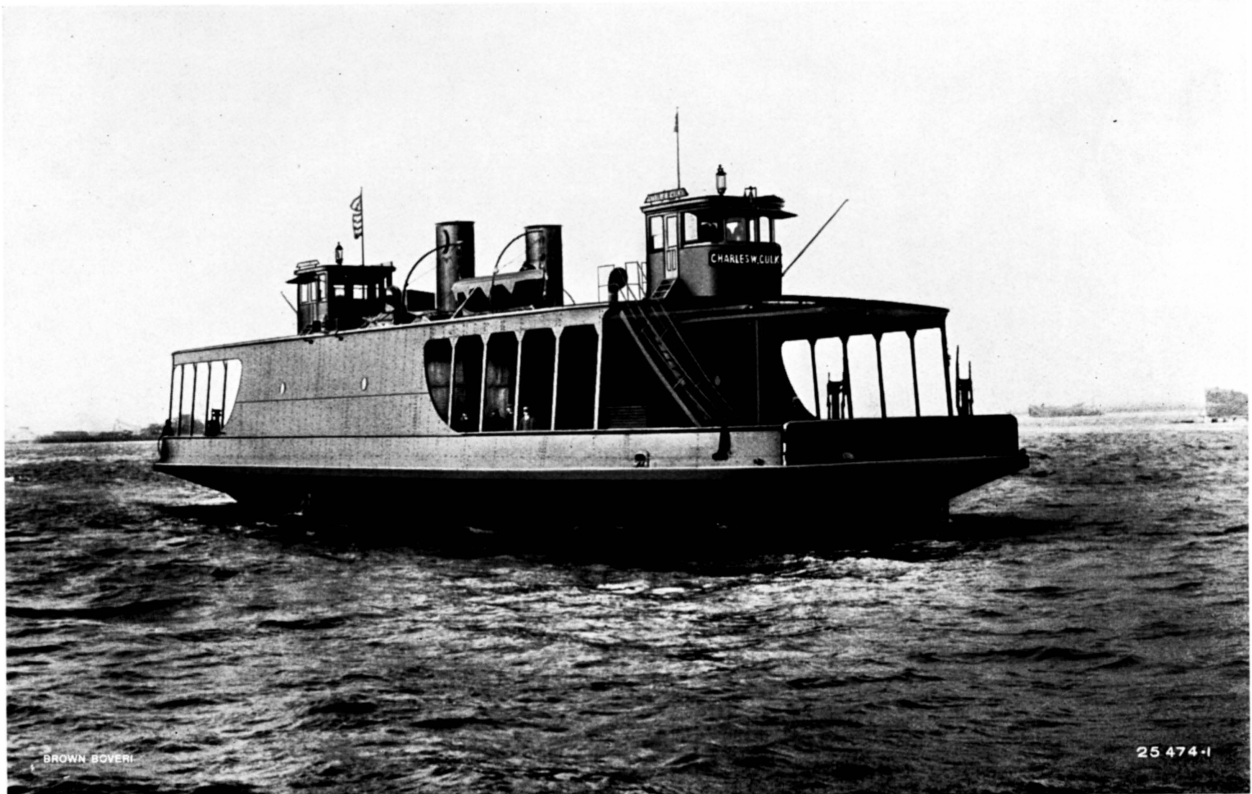
FÄHRBOOT MIT DIESELELEKTRISCHEM ANTRIEB UND STEUERUNG VON DER BRÜCKE AUS IM HAFEN VON NEW YORK. (Sechs solcher Fährboote sind von der American Brown Boveri Electric Corporation, Camden, für den New Yorker Hafen gebaut worden.)
