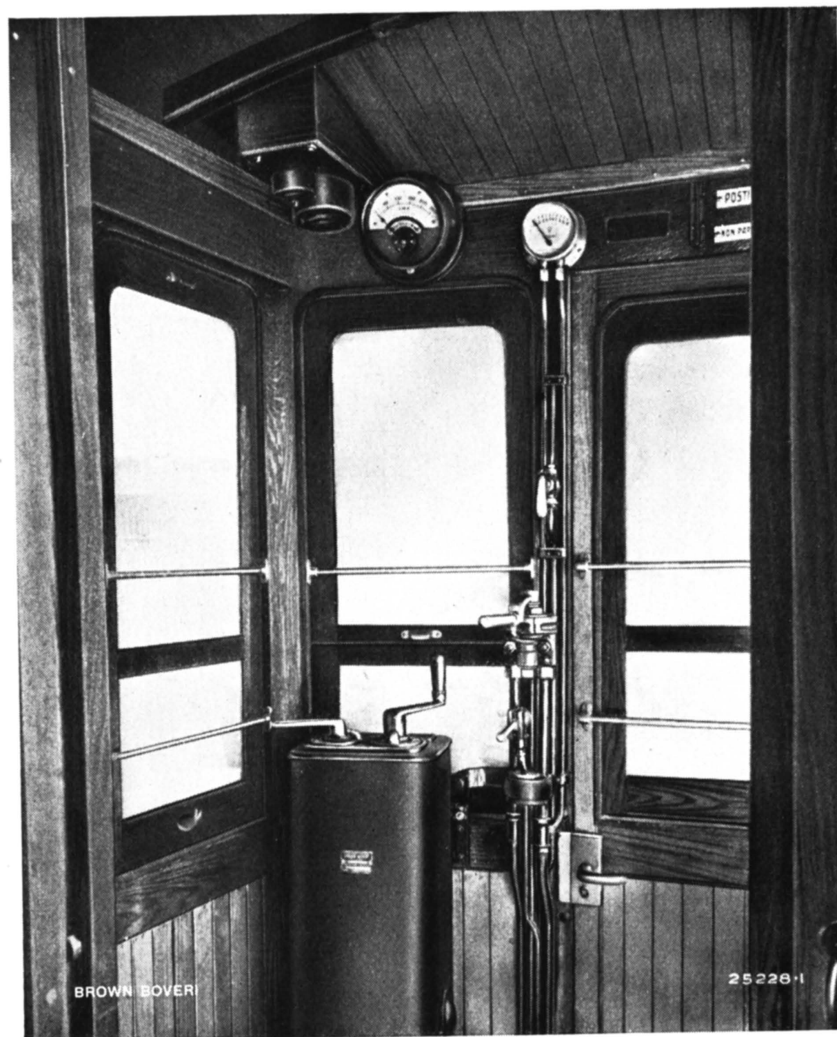
Abb. 3. — Führerstand mit dem in einem Apparat mit der Wendewalze vereinigten Steuerkontroller.
